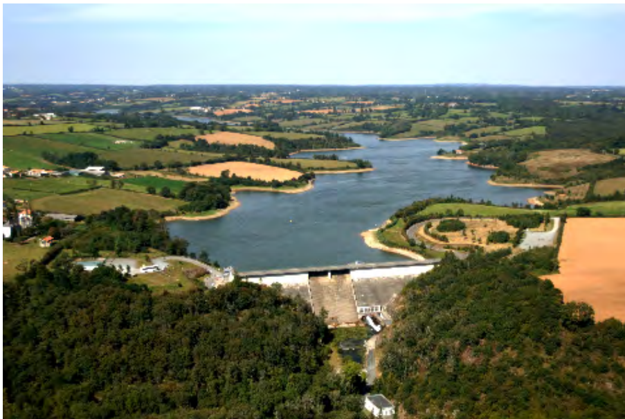
Figure 17. Le barrage de La Touche Poupard. Source : www.caeds.fr
