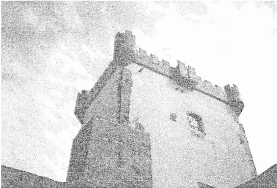
Photographie n° 21 : Asilah : La tour de Menagem et sa sur-élévation
