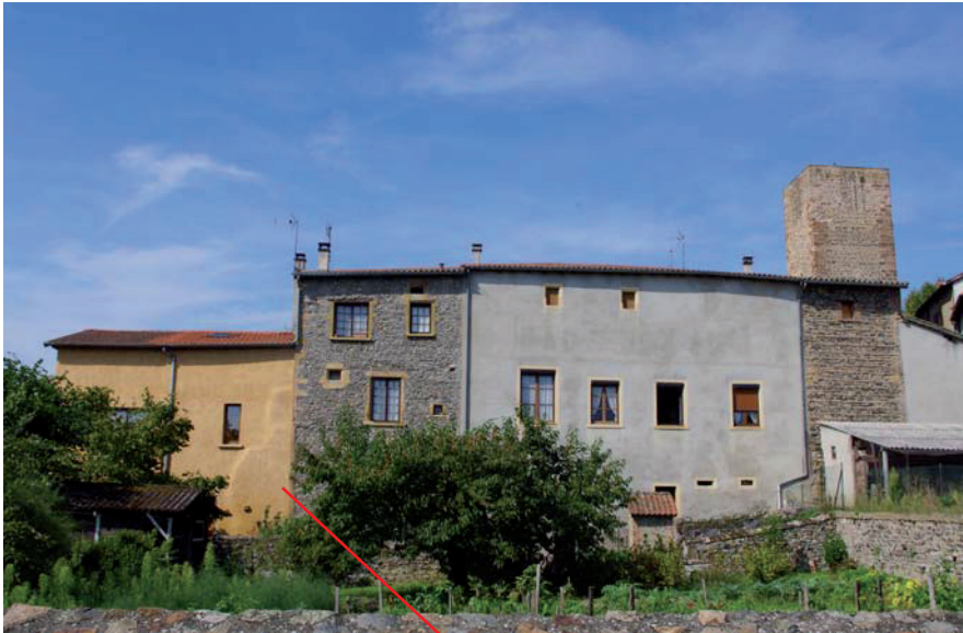
Maisons alignées à l'ouest du jardin central : vue générale depuis l'est
