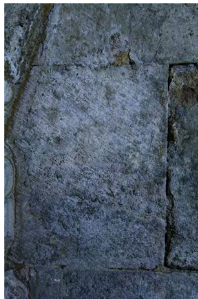
Pierre p 28 : layage diagonal
