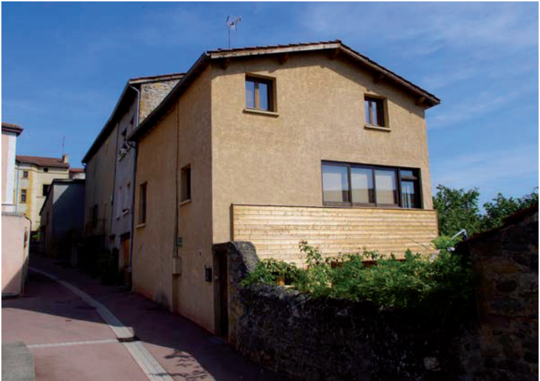
Maison sud-ouest : vue générale depuis le sud-ouest
