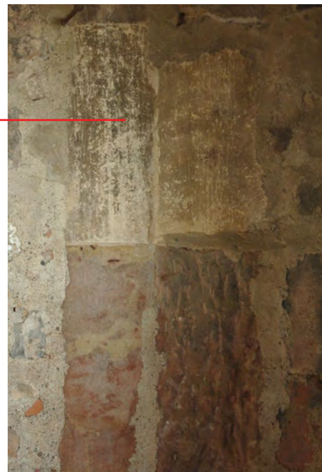
Détail du fût du support n° 3
