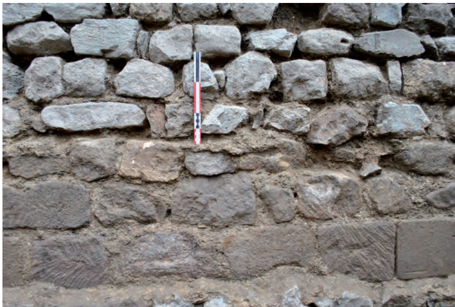
D 5.19 Sondage S 4 : lambeau d'un niveau de mortier du deuxième sol
