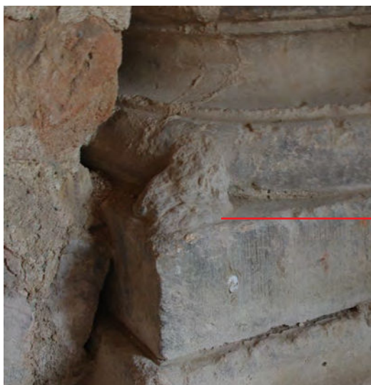
Détail de la griffe sur la base du support n° 3
