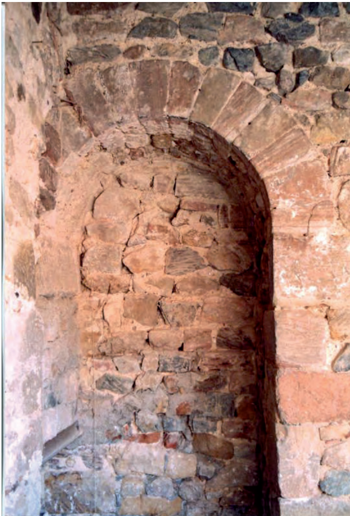
C 2.13 Cuvier, mur est, parement externe : arcade aveugle (b 17)
