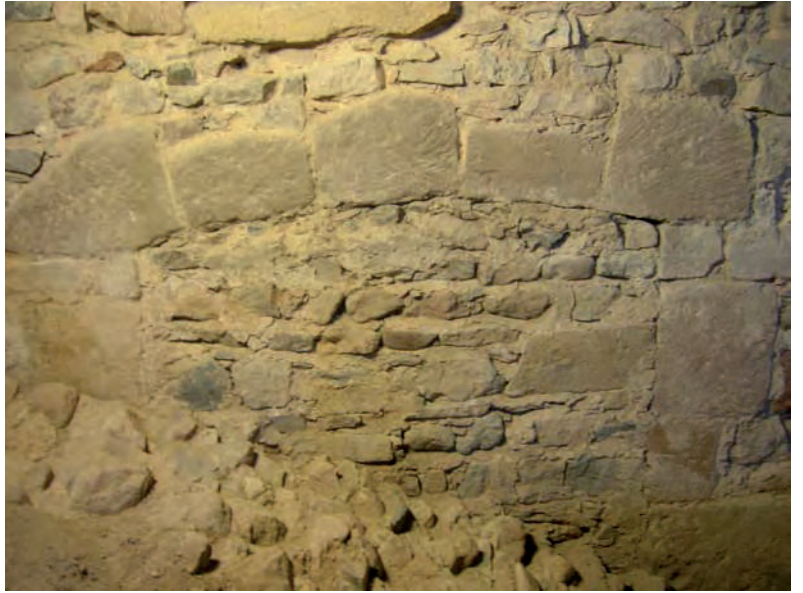
C 2.78 Cuvier, mur sud, parement interne : porte (b 7)
