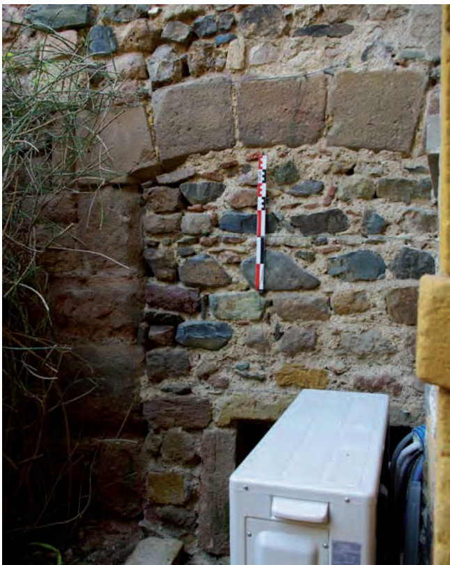
C 2.79 Cuvier, mur sud, parement externe : porte (b 7)
