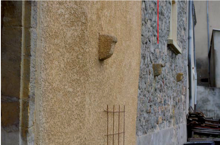
Maison sud-ouest, élévation est : alignement de trois corbeaux
