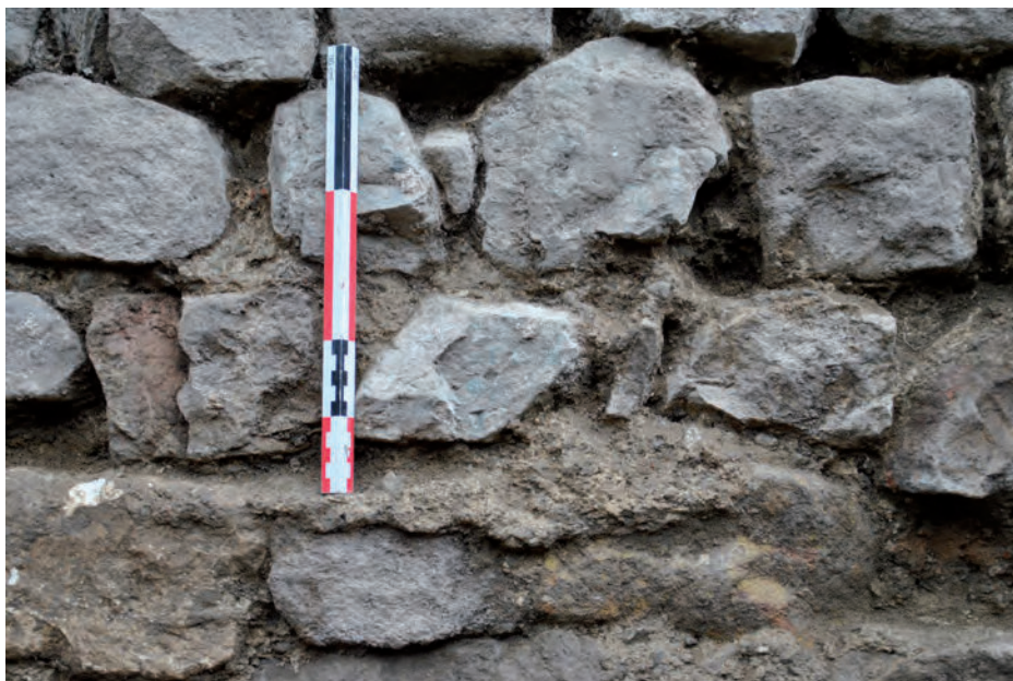
D 5.20 Sondage S 4 : détail du niveau de mortier du deuxième sol
