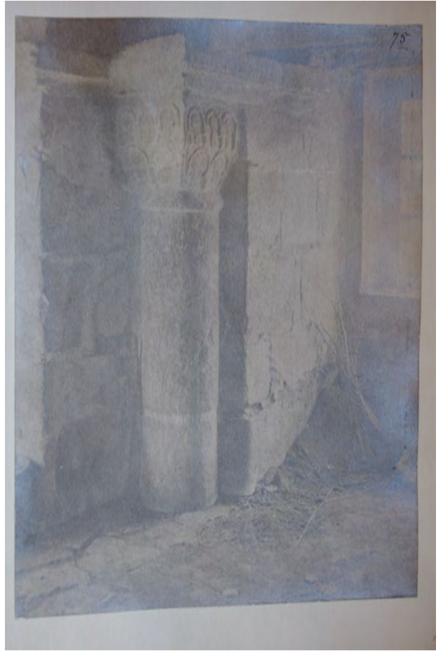
C 1.17 Chapelle Saint-Léger : vue de l'angle sud-est, prise par A. Cateland (av. 1914)
