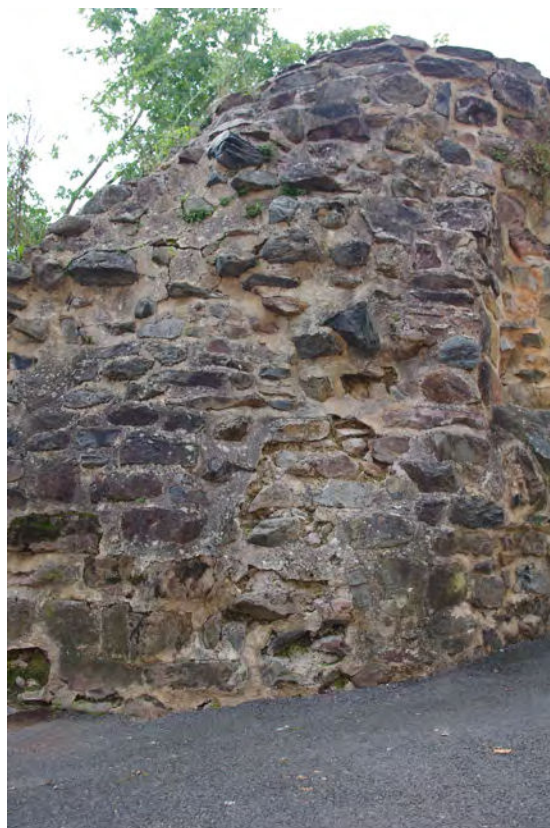
Jardins ouest, mur nord, parement externe : mur d'une tourelle d'escalier ?
