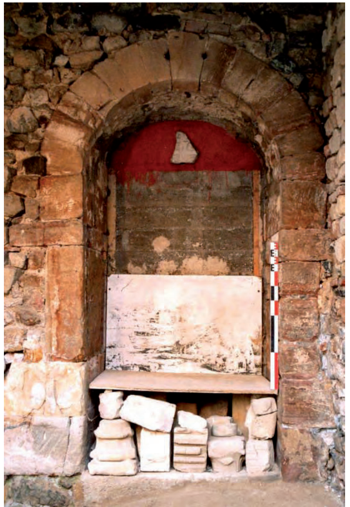
C 2.12 Cuvier, mur est, parement externe : porte centrale (b 16)
