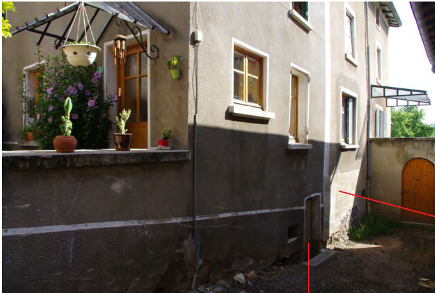
Entrée de la cave ouest
