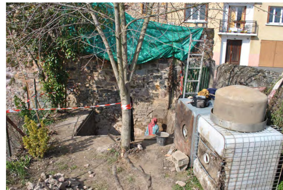
Jardins ouest, sondage S 3 : vue générale
