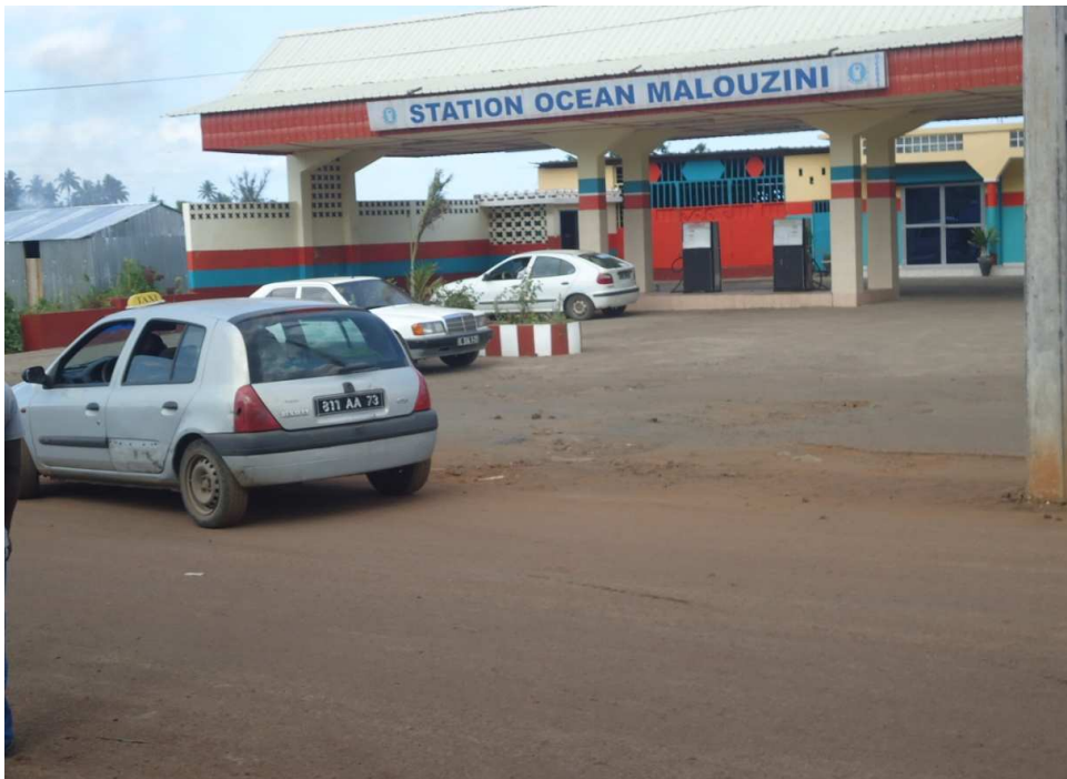
Ph. 62. Une des 2 grandes stations de la nouvelle zone Malouzine
