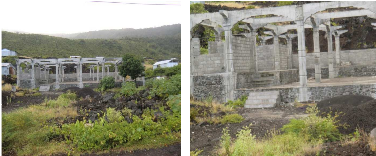
Ph. 28. Place publique de Itsundzuu Mbadjini en construction
