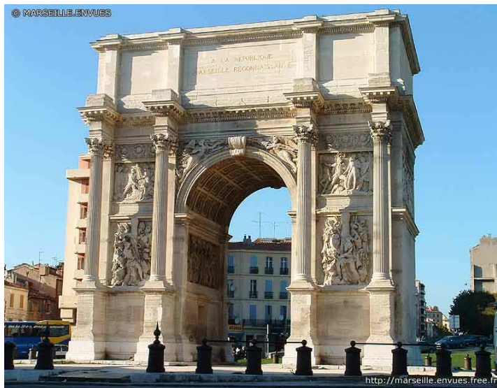
Ph. 16. La porte d'Aix au centre de l'ancienne place d'Aix
