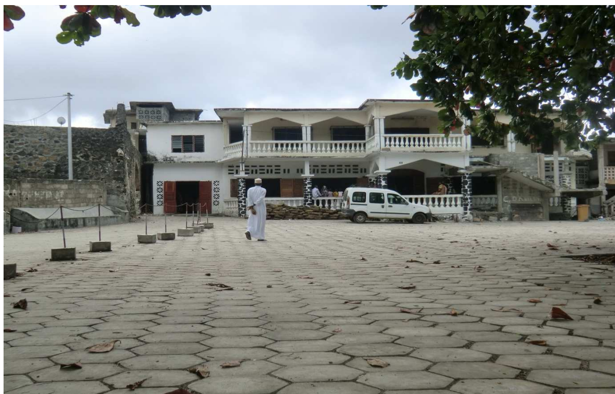
Ph. 25. Second foyer en cours de construction (en réaction)
