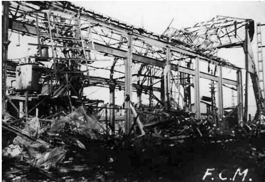
Illustration 15 : Les ateliers des chantiers navals de La Seyne-sur-Mer suite aux bombardements de 1944 663
