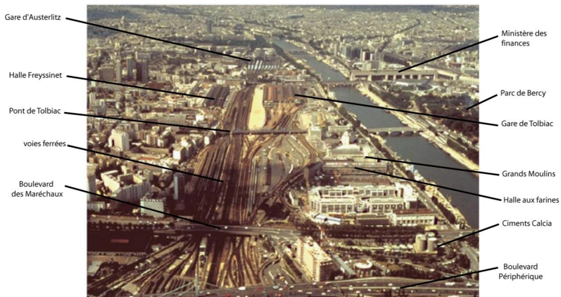
Figure 14. Vu aérienne du secteur dans les années 1980 (APUR, 1990)
