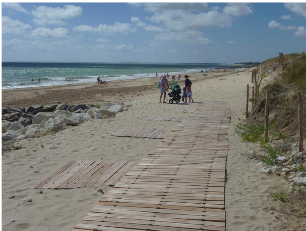
Photographie 24. Chemin de plage en caillebotis sur l'île de Ré
