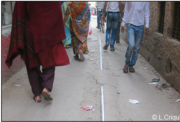
Photo 48/D. Mini-tranchée superficielle (Delhi, Sheikh Sarai, 10/03/2013)
