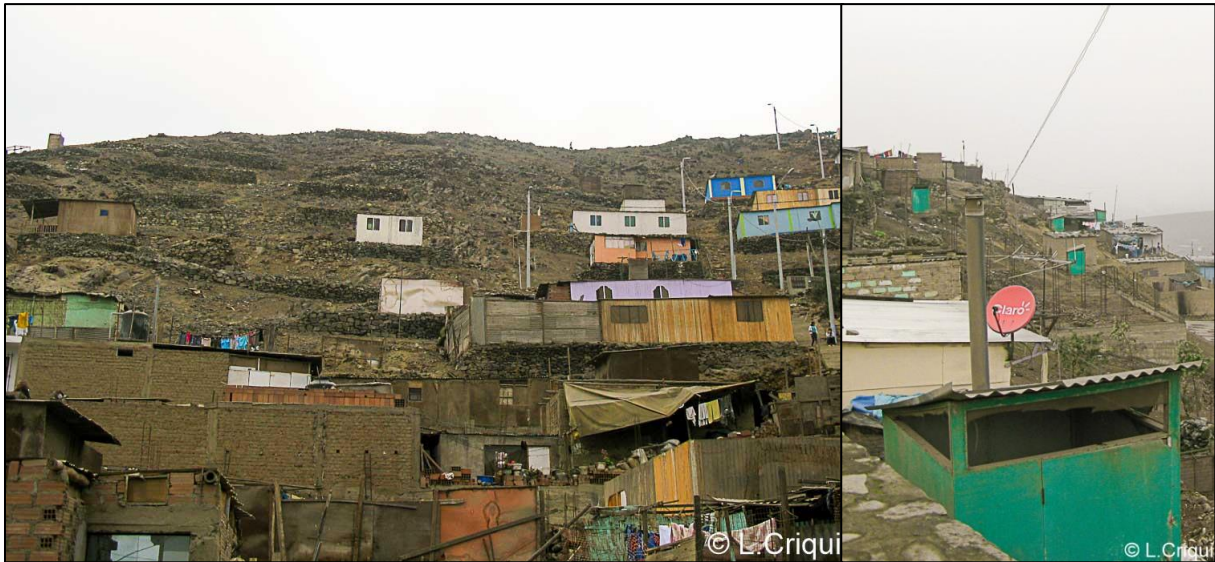
Photo 20/L. Construction sur plateformes précaires (Lima, Comas, Collique, 16/08/2012)
