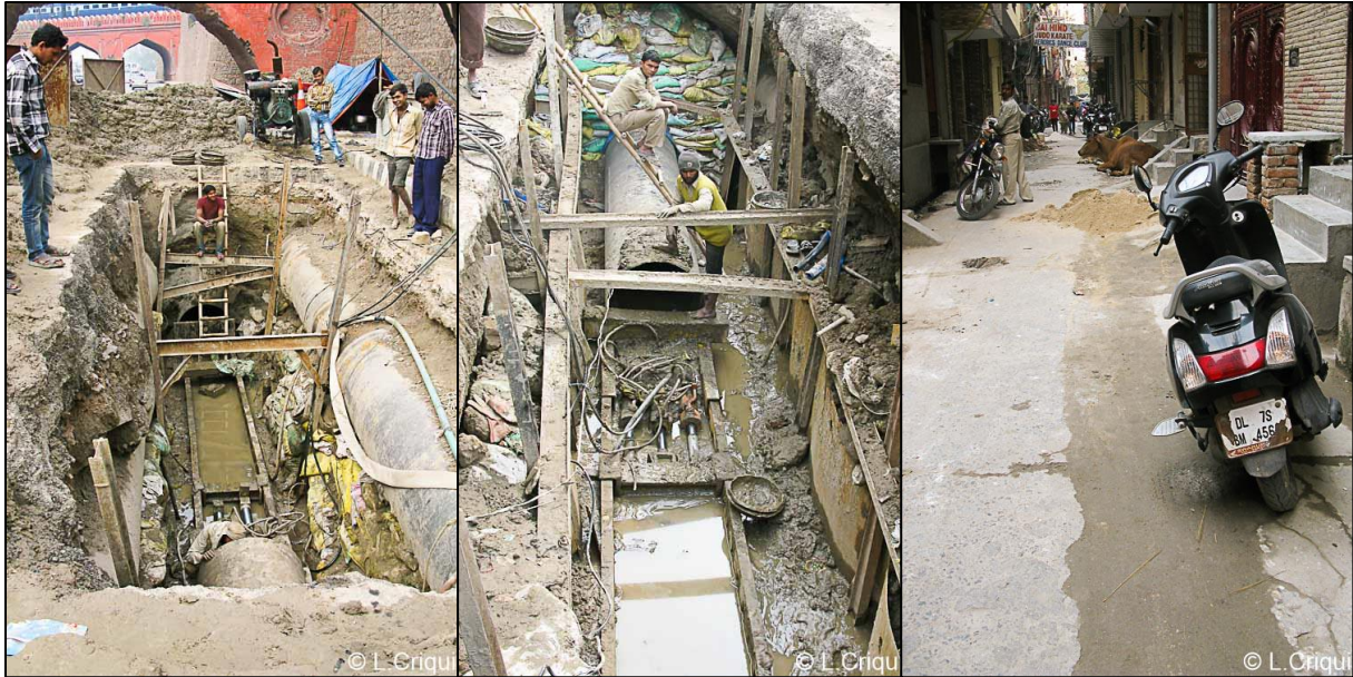
Photo 87/D & Photo 88/D. Enfouissement sans tranchée 113 (Delhi, Old Delhi, 19/02/2013)
