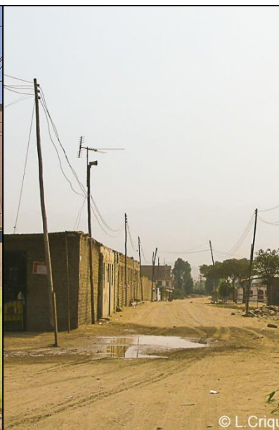
Photo 37/L. Poteaux en bois provisoires
