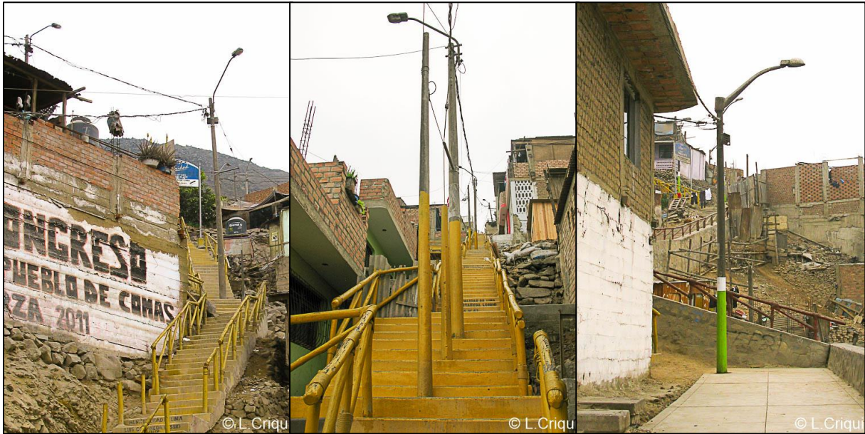
Photo 84/L. Poteau encastré
