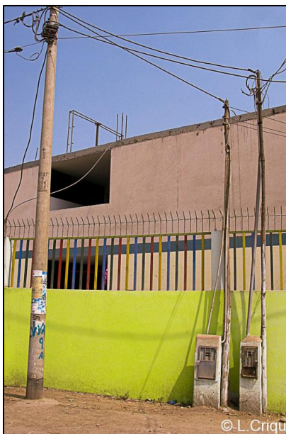
Photo 36/L. Dernier poteau du réseau et macro-compteur
