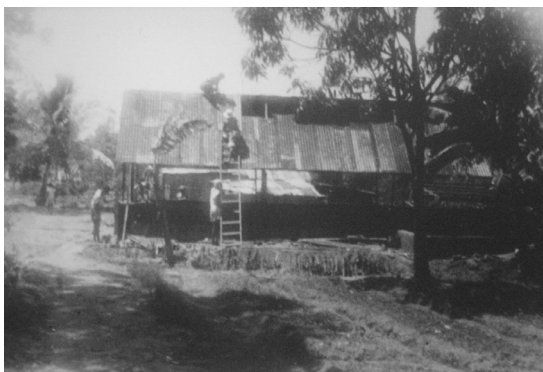
ER de Farafangana, pose de la toiture, 1948 Source : ARM G143, photo de René Pallissière
