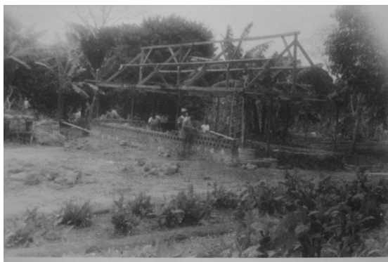
ER de Farafangana, édification des murs, 1948 Source : ARM G143, photo de René Pallissière
