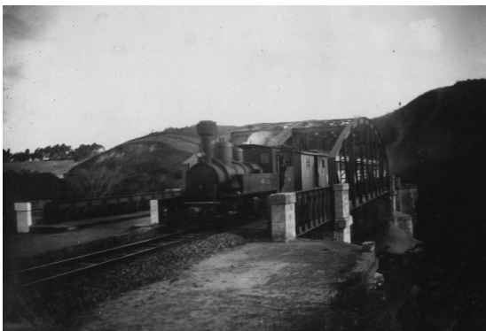
Pont de la Manara, 1937 Source : Fond Georges Duteil
