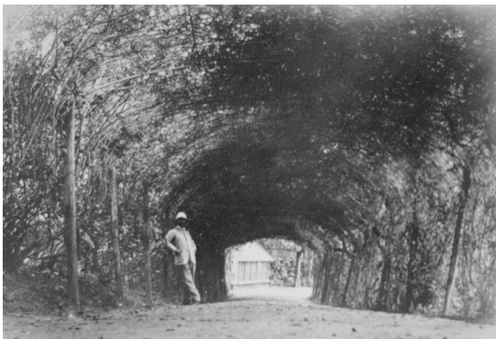
Sosthène Pénot dans le jardin de la résidence, 1906 Source : Fond Sosthène Pénot
