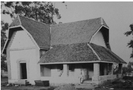
Ecole d'Ambatondrazaka, maison du directeur en travaux, 1947 Source : ARM G143, photo de Pallissière
