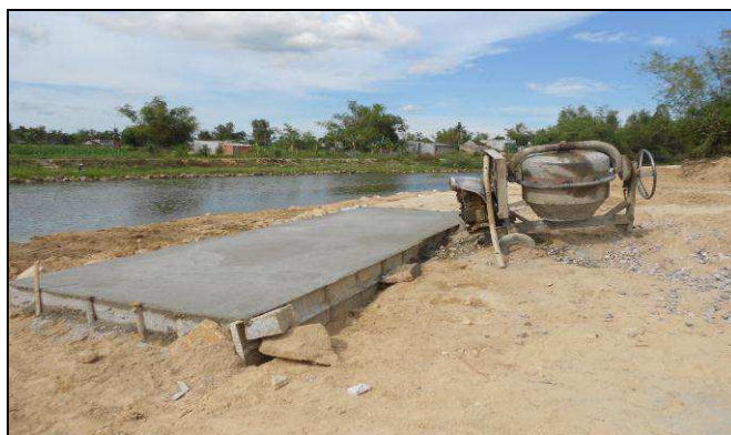
Photographie 6.9. Digue en construction sur le fleuve Ha Thanh (Photographie : Ngo, 2012)
