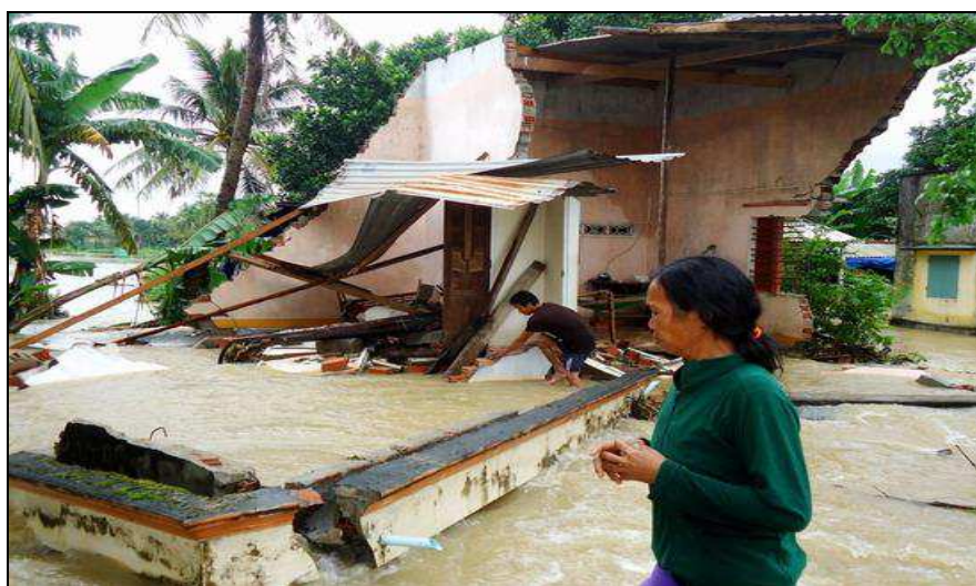
Photographie 6.12. Maison endommagée de Đòng Văn Cường du district de Phu My (en aval du fleuve Kon) (Photographie : XUAN Loc, 17 novembre 2013 15h)
