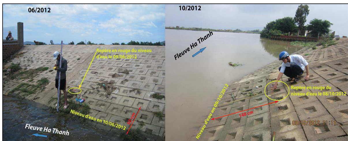
Figure 3.22. Différence de niveaux d'eau sur le fleuve Ha Thanh (Ngo, 2012)
