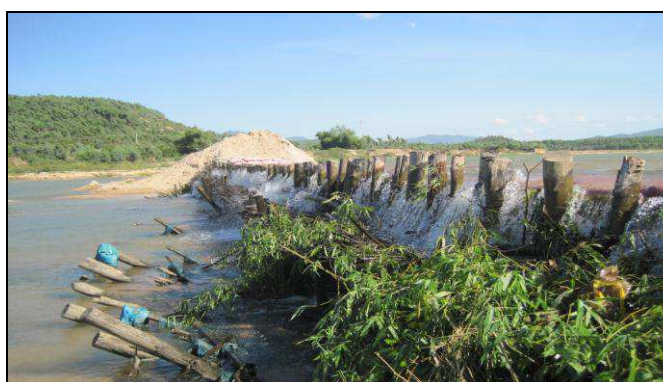
Photographie 6.10. Barrage construit en bambous sur le fleuve Ha Thanh (Photographie : Grivel, 2012)
