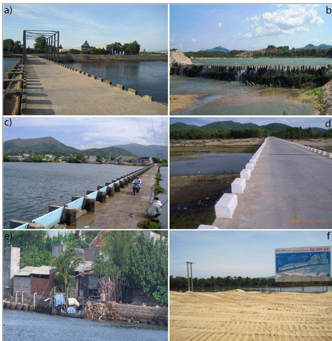
Figure 4.30. Exemple de barrage-seuil et de barrage-écluse dans le delta du fleuve Ha Thanh
