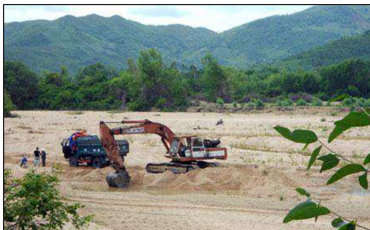
Photographie 4.8. Extraction de sable dans le lit mineur du fleuve Ha Thanh (Source: http://www.cand.com.vn , 2012)
