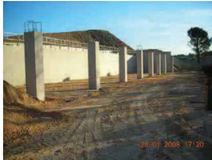
Voile béton et poteaux, Janvier 2008
