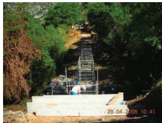
Débroussaillage et terrassement du lieu d'implantation et Préparation de l'échafaudage, Avril 2008
