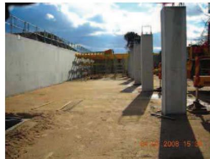
Mise en place de l'échafaudage pour le coulage du plancher, Février 2008
