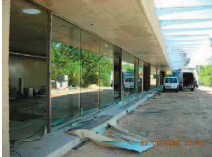
Pose des vitrages, Avril 2008
