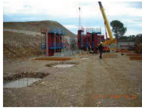
Coulage des murs enterrés, Janvier 2008
