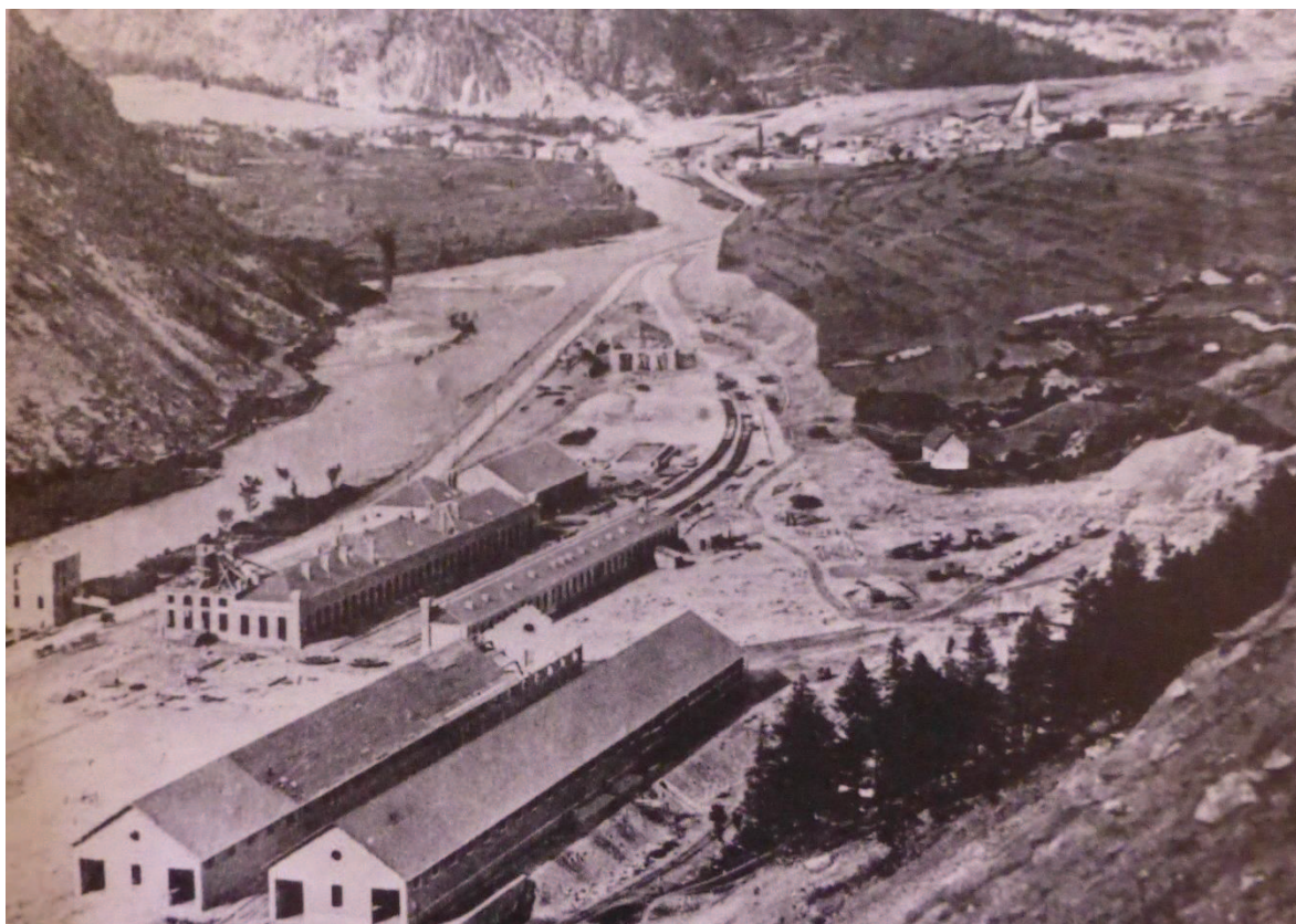
Photographie 46. Vue de la gare de Modane en construction en 1870 (R. RATEL, Le tunnel ferroviaire du Fréjus, 1857-1995 , Saint-Jean-de-Maurienne, Imp. Roux, 1997, p. 103).
