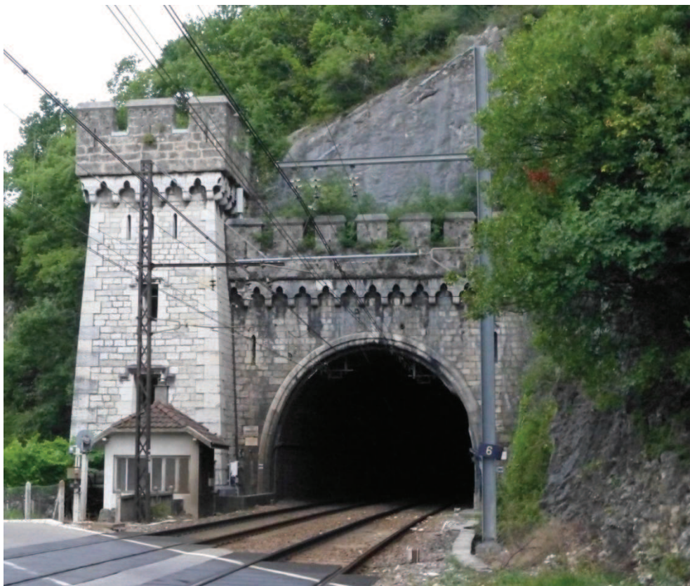
Photographie 31 b. Entrée du tunnel ferroviaire de Brison du côté d'Aix-les-Bains (E. Cottet Dumoulin, juillet 2013).
