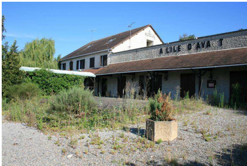
Figure 117 : Point de vue 095 □ Comme une verrue plantée à l'entrée de la ville Auteur : Pierre Perignon
