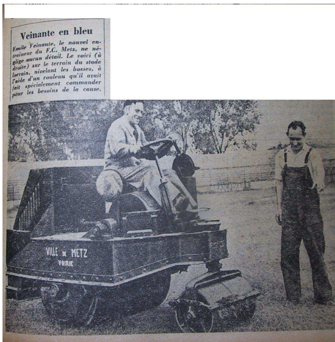
France Football n° 231, 22 août 1950. Émile Veinante surveille le nivellement du terrain d'entraînement du F.C. Metz.
