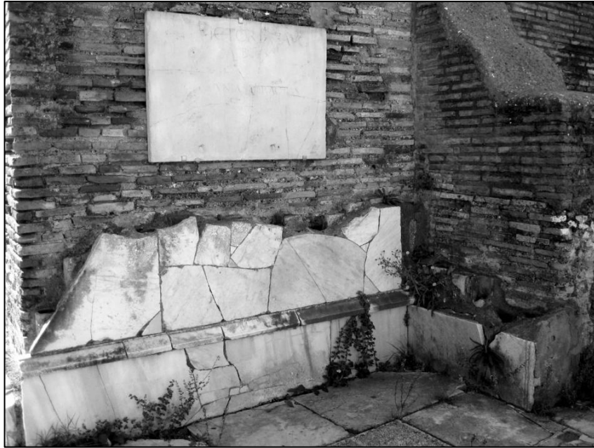
Figure 38 : Placages en marbre blanc recouvrant le sol et les parois du caldarium des thermes du Forum, Ostie (cliché A. L. Foulché)
