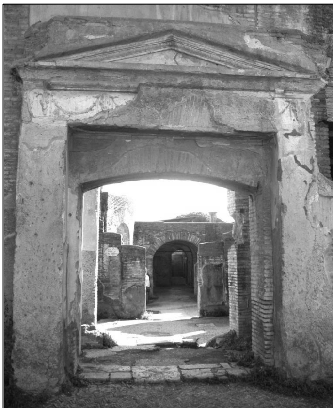
Figure 13 : Accès monumental aux thermes des Sept Sages, depuis l' insula degli Aurighi, Ostie (cliché A. L. Foulché)
