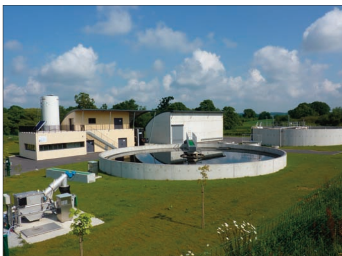
Photo 15. Station d'épuration à boues activées de Locqueltas
