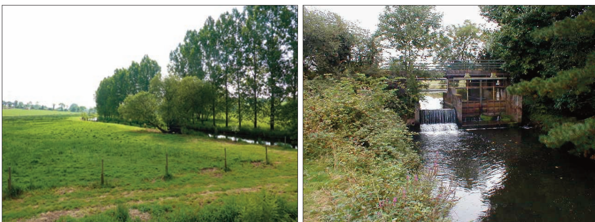
Planche photo 6. Section recalibrée du Loc'h ( gauche ) et ouvrage hydraulique installé sur son cours supérieur lors des opérations de remembrement ( droite )
