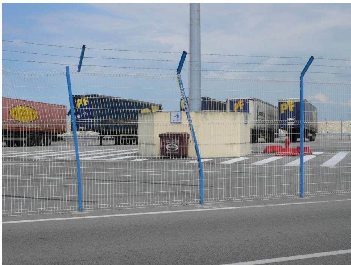
Photo n°9 - Les grilles du parking nord de la gare maritime réservé aux poids lourds. Les passages répétés des migrants ont endommagé ce dispositif «anti-intrusion». [OT, 08/04/2008]
