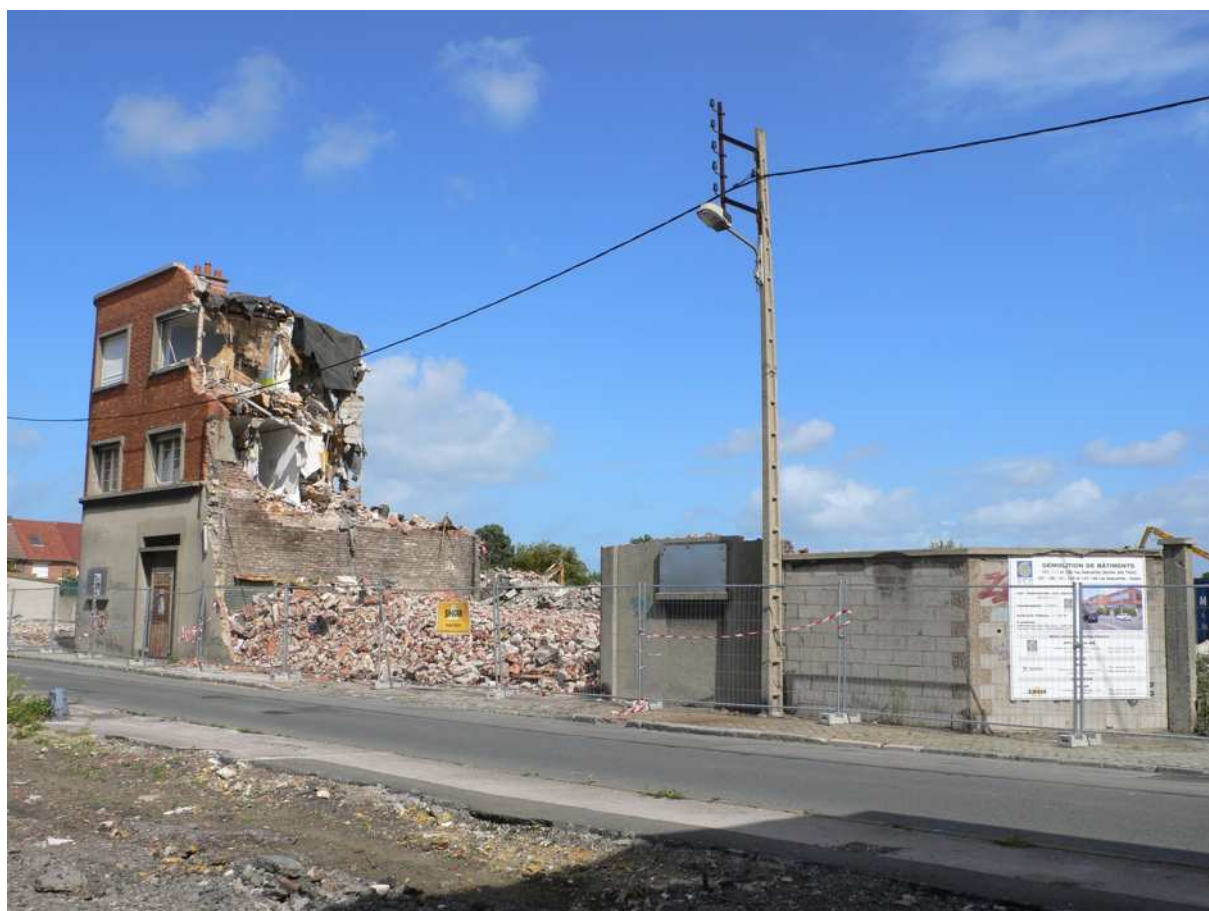
Photo n°39 - La destruction en cours de l' African house sur le site de l'ancienne usine Thélou à Calais. A l'emplacement de cette friche industrielle, la municipalité a programmé la construction d'un éco-quartier dont la livraison est annoncée pour septembre 2013. [OT, 05/09/2011]
