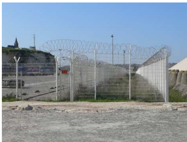
Fig. 2.4.3 ; Port de Dieppe. La clôture autour du parking poids lourds a été doublée. Un fossé déjà existant a été utilisé pour créer un obstacle supplémentaire. Des barbelés rasoirs y ont été installés. OT, 20.04.11
