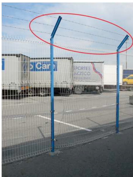
Fig. 2.6.20. ; Les bavolets installés autour du parking des poids lourds sur le port de commerce de Cherbourg. OT, 08.04.08.
