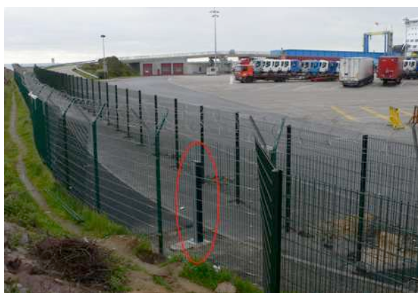
Fig. 2.4.5. ; Le port transmanche à Ouistreham. Entre les deux clôtures, une barrière infra-rouge a été installée pour détecter d'éventuelles intrusions en direction du parking des poids lourds. OT, 30.04.08.
