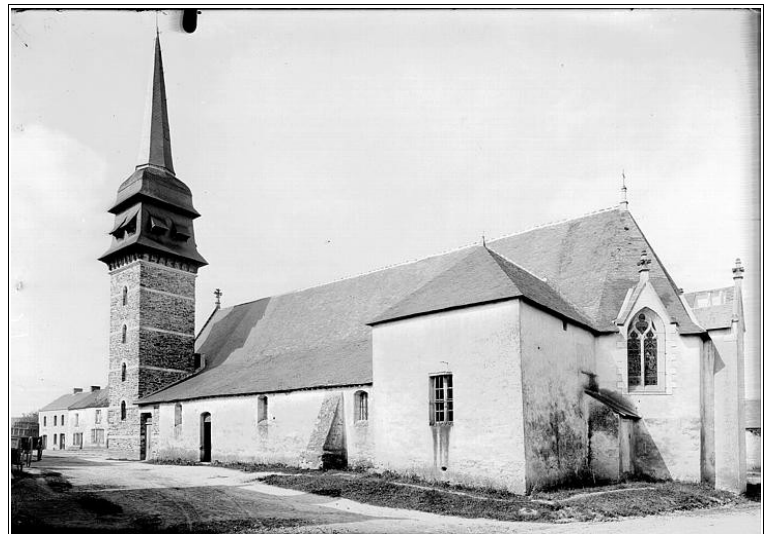
Illustration 77 Vue extérieure de l'église Photographie par Estève, 1922 (ACMH 0084/044/1002)
