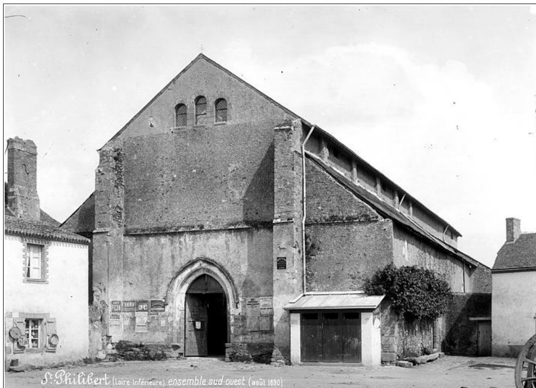
Illustration 110 Vue extérieure : photographie par M. Mieusement, 1890 (ACMH 0084/044/1005)
