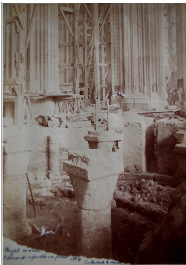
Illustration 187 : dégagement de la crypte, [1884] : photographie (ACMH 0082/044/1003)
