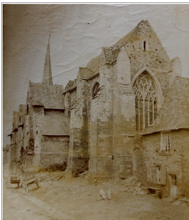
Illustration 90 Ancienne église Photographie par F. Bougouïn, [ca 1883] (AHDN P Saint-Julien de Vouvantes, Y 3)
