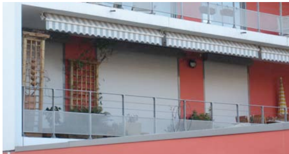
Hiver 2006-2007 Vue sur la loggia depuis une rue adjacente
