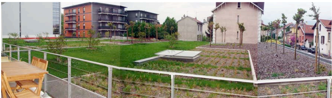
Toiture végétalisée sur parking, inaccessible et sur cœur d'îlot. Vue depuis un appartement du 1 er étage. Résidence l'Orangeraie, Quartier de la Bajatière, Grenoble. (Photo personnelle 2004)
