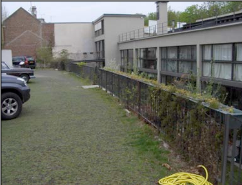
Depuis l'espace du parking au même niveau que la rue vers les jardins en décaissé
