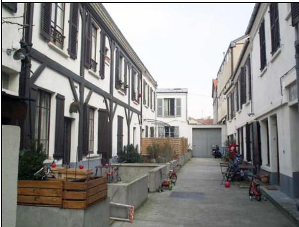
Vue sur la venelle depuis le portail d'entrée
