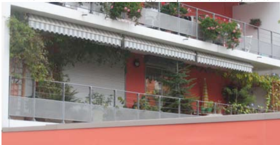
Automne 2007 Vue sur la loggia depuis une rue adjacente
