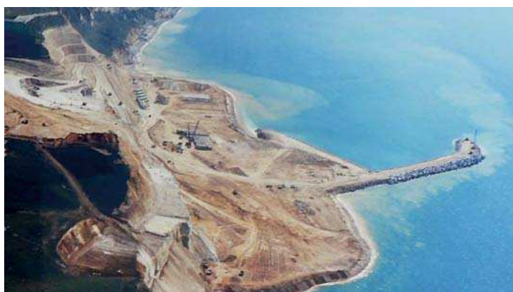
Photo 34 : Chantier du port pétrolier d'Antifer. Source AREHN.
