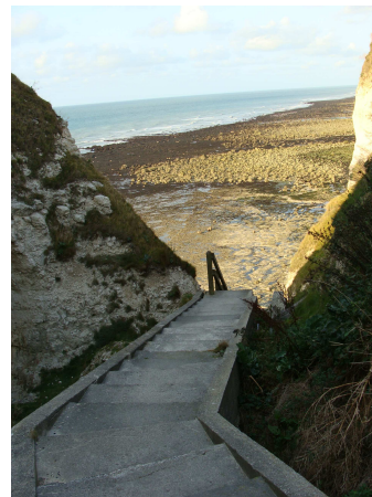
Photo 26 : Escalier du Val d'Ausson, aujourd'hui officiellement fermé permettant d'accéder à la plage.
