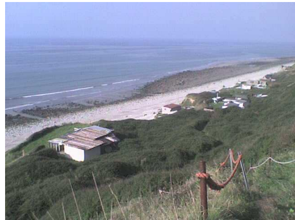
Photo 29: A droite de la plage, un "village" de cabanes installé sur des éboulis de falaises
