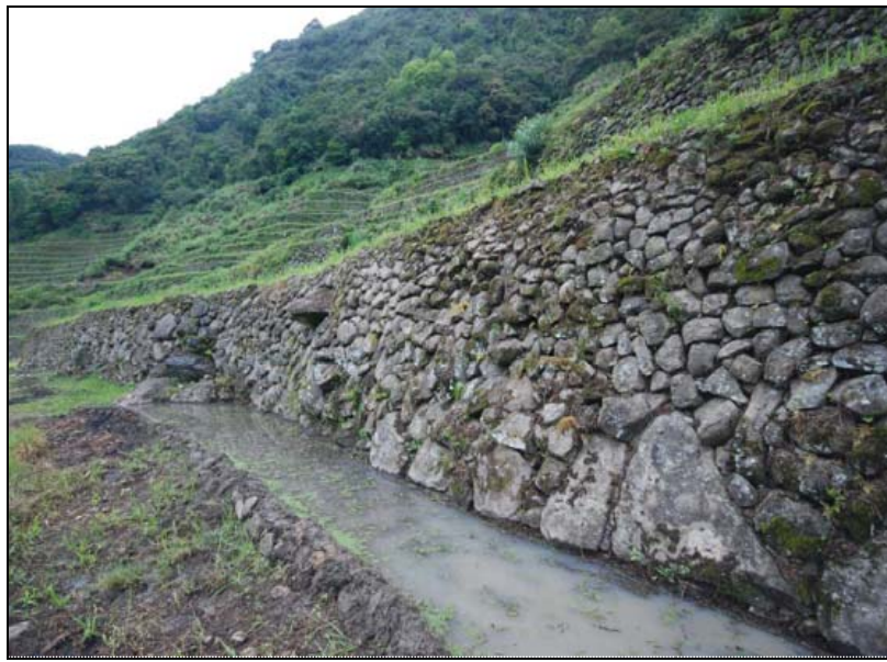
Photo 6.2. Retenue d'eau en vue de réparer le mur de la terrasse du dessous à Batad (Banaue, avril 2008).
