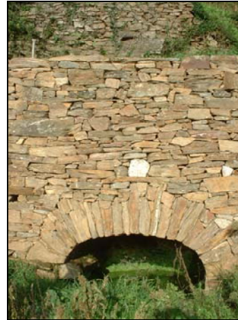
Photo 7.3. Gourgue sous une terrasse voûtée à Saint-Jean-du-Gard (octobre 2007).
