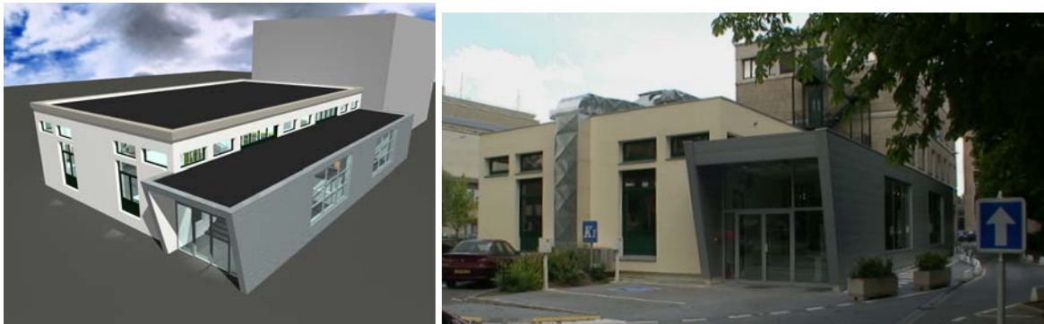
Figure 19: Le bâtiment K1 (maquette et vue extérieure)
