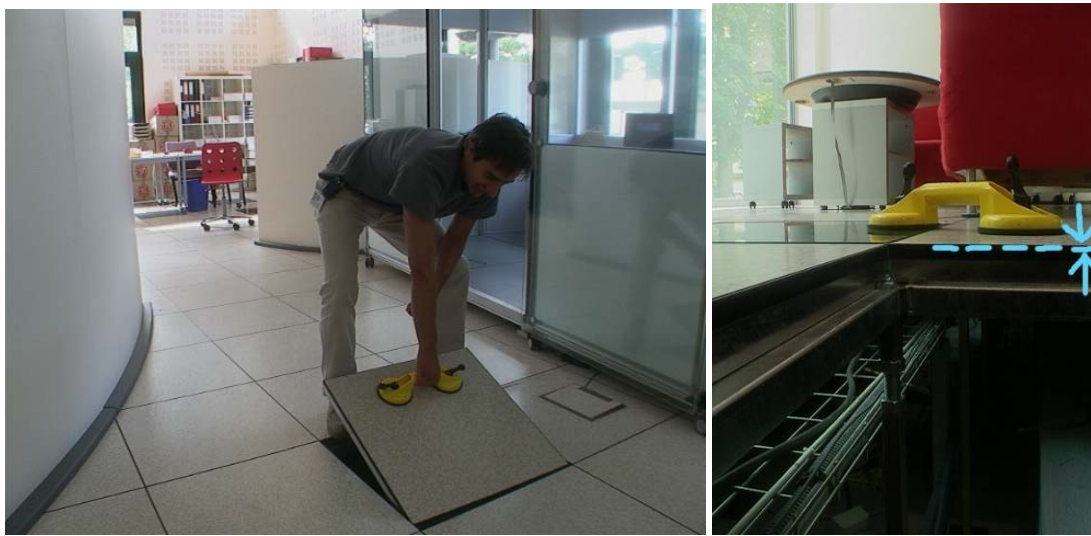
Figure 25 a, b, c: sous le faux plancher amovible, une infrastructure flexible distribuée en n'importe quel point air, courant électrique, voix et données à haut débit.
