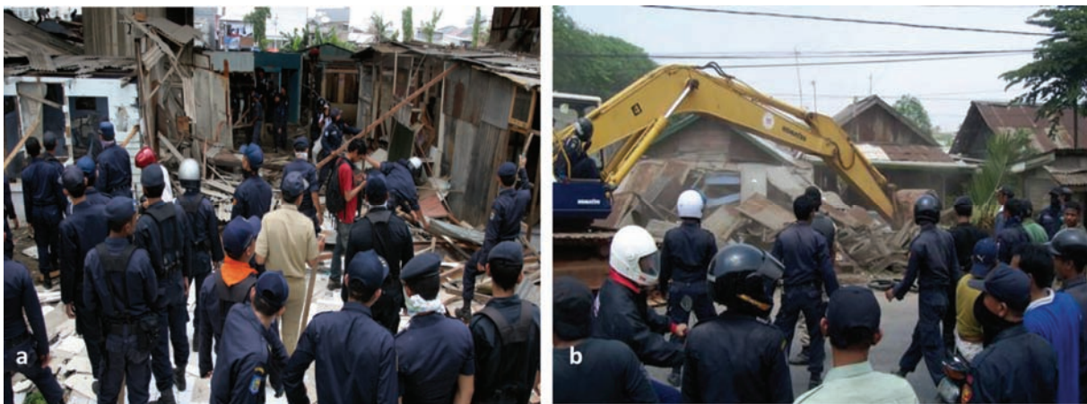
Figure 6.21. a : opération d'expulsion par l'armée dans un kampung ( http://ariyanto.files.wordpress.com ) ; b : Destruction au bulldozer d'un kampung à Cakung Cilincing, Jakarta Nord en 2005 (LBH – Jakarta).
