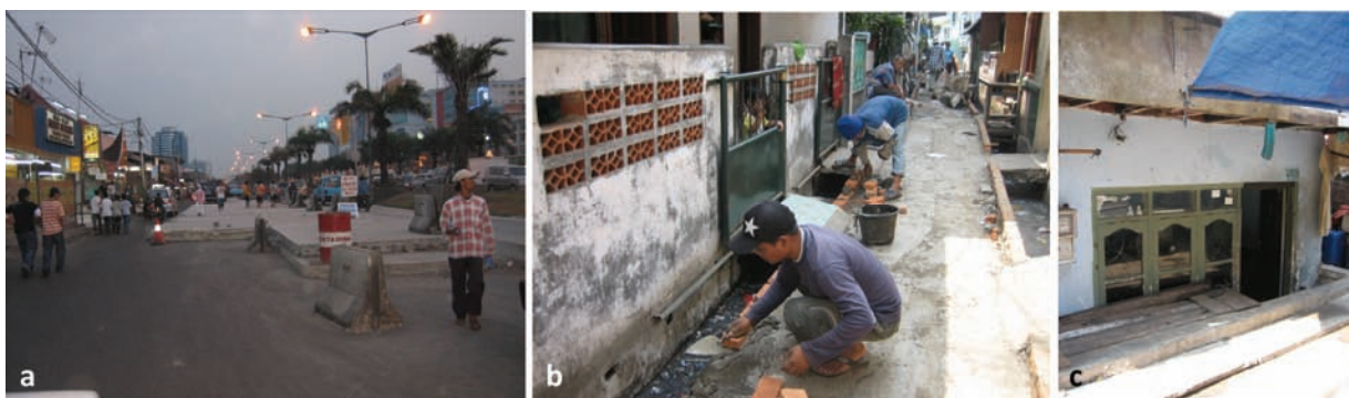
Figure 2.15. La nécessaire surélévation du bâti comme conséquence et indice de la subsidence : (a) : surélévation de la rue principale jalan Gunung Sahari ; b : surélévation d'une ruelle ; c : maison qui n'a pas été surélevée, plancher à 50 cm en dessous du niveau de la ruelle. Clichés P. Texier, Pademangan Barat, septembre 2006).
