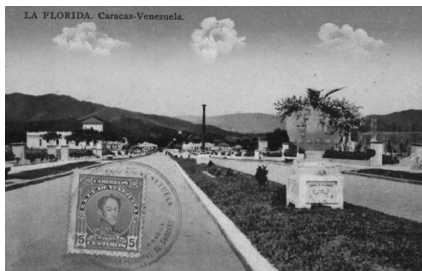
Figure 41. Urbanización de La Florida aux larges avenues et aux résidences basses et unifamiliales, au Nord de Sabana Grande au milieu des années 1920
