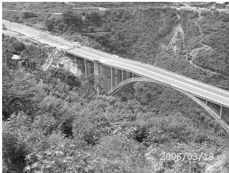
Photo 2. Vue plongeante sur le viaduc la veille de son effondrement, depuis le côté La Guaira
