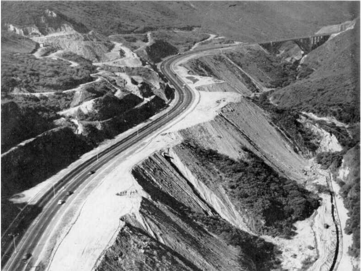
Photo 4. Terrassements monumentaux opérés au pied de versants pour permettre le tracé de l'autoroute.
