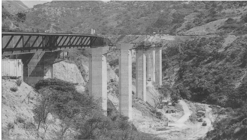
Photo 8. Vue du nouveau viaduc depuis le côté littoral
