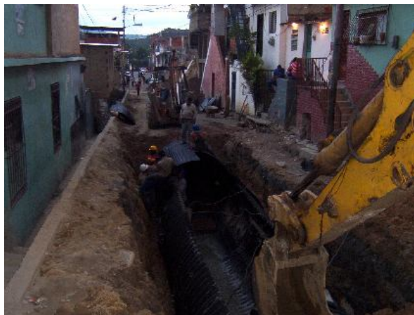
Photo 26. Curage de la conduite enterrée d'une ravine busée dont le lit mineur est densément occupé par une des rues principales du barrio Santa Rosa, près de la Plaza Venezuela (Source : Cliché de l'auteur, 2002).
