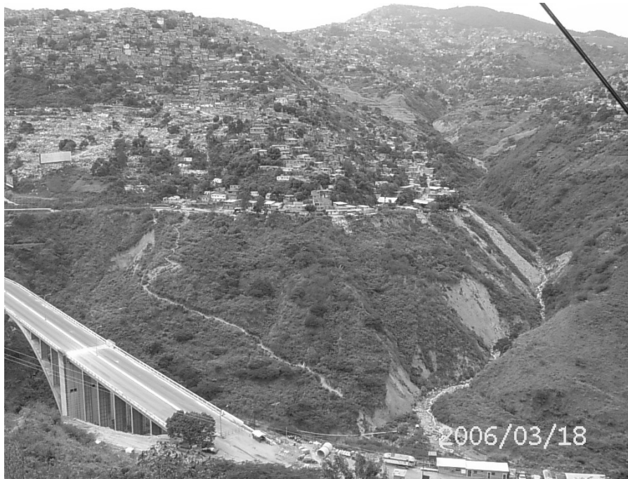
Photo 6. Vue de Nueva Esparta après la fermeture du viaduc et la veille de son effondrement (Source : Courtoisie de la Protection Civile Métropolitaine)
