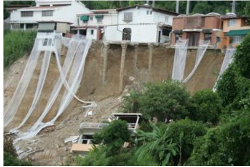
Photo 9. Glissement de terrain à Santa Ines (Source : Tiré de El Universal 11 janvier 2006)
