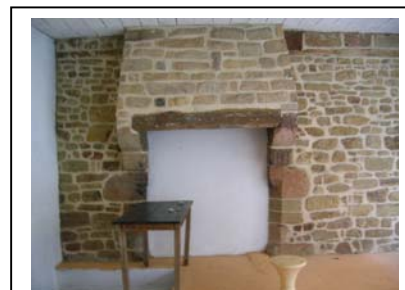
Cheminée du N°31 rue du Château, rez-de-chaussée.
