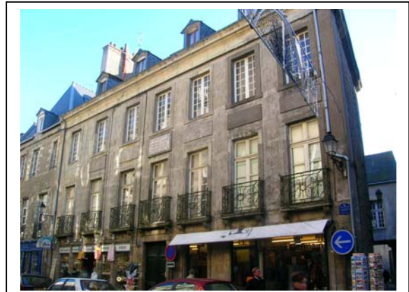
Hôtel Dondel, rue St Vincent, Vannes. Photo : Julien DANIELO
