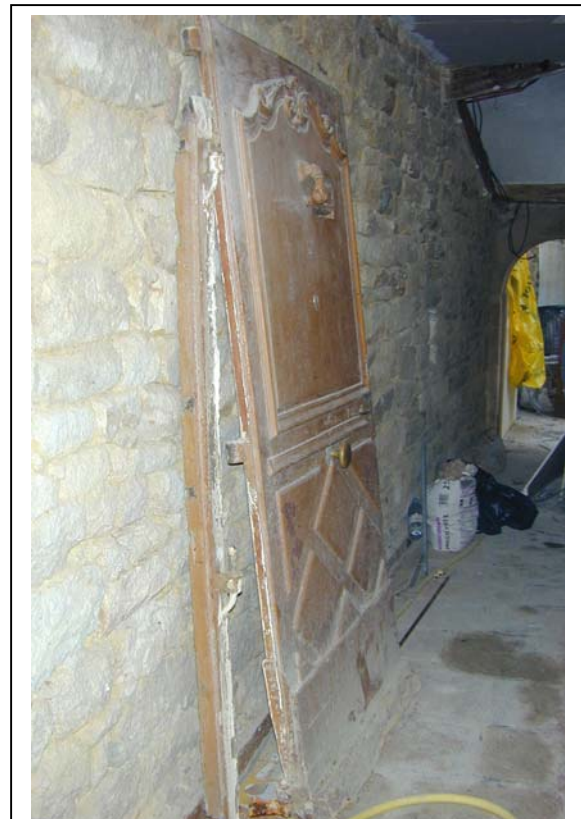
Porte du N°3 rue Richemont prise peu de temps avant sa disparition en 2001. Photo : Catherine TOSKER : IVR53_015604287NUCA_2
