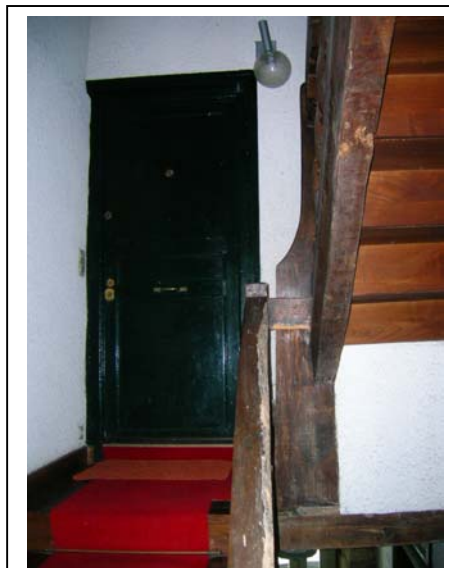
Escalier du N°15 rue Ferdinand Le Dressay (Hôtel Desruisseaux) 2 nd e ½ du XVIIIe siècle.
