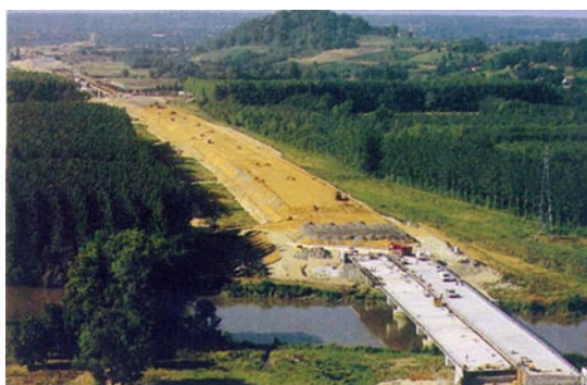
Document n°18 : Le chantier de l'A89 dans les palus de la basse vallée de l'Isle (photo ASF)
