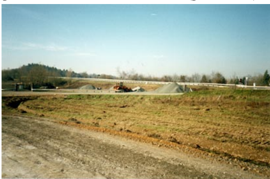
Photo n°A54 : La traversée des palus par l'A89
