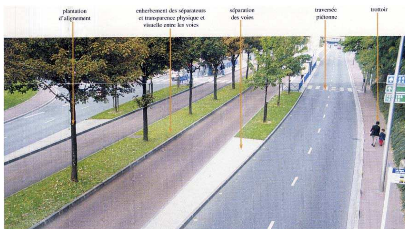
Les boulevards urbains : Regualification d'une route nationale en boulevard urbain, ici en région Parisienne (Val-de-Marne, RN 186)
