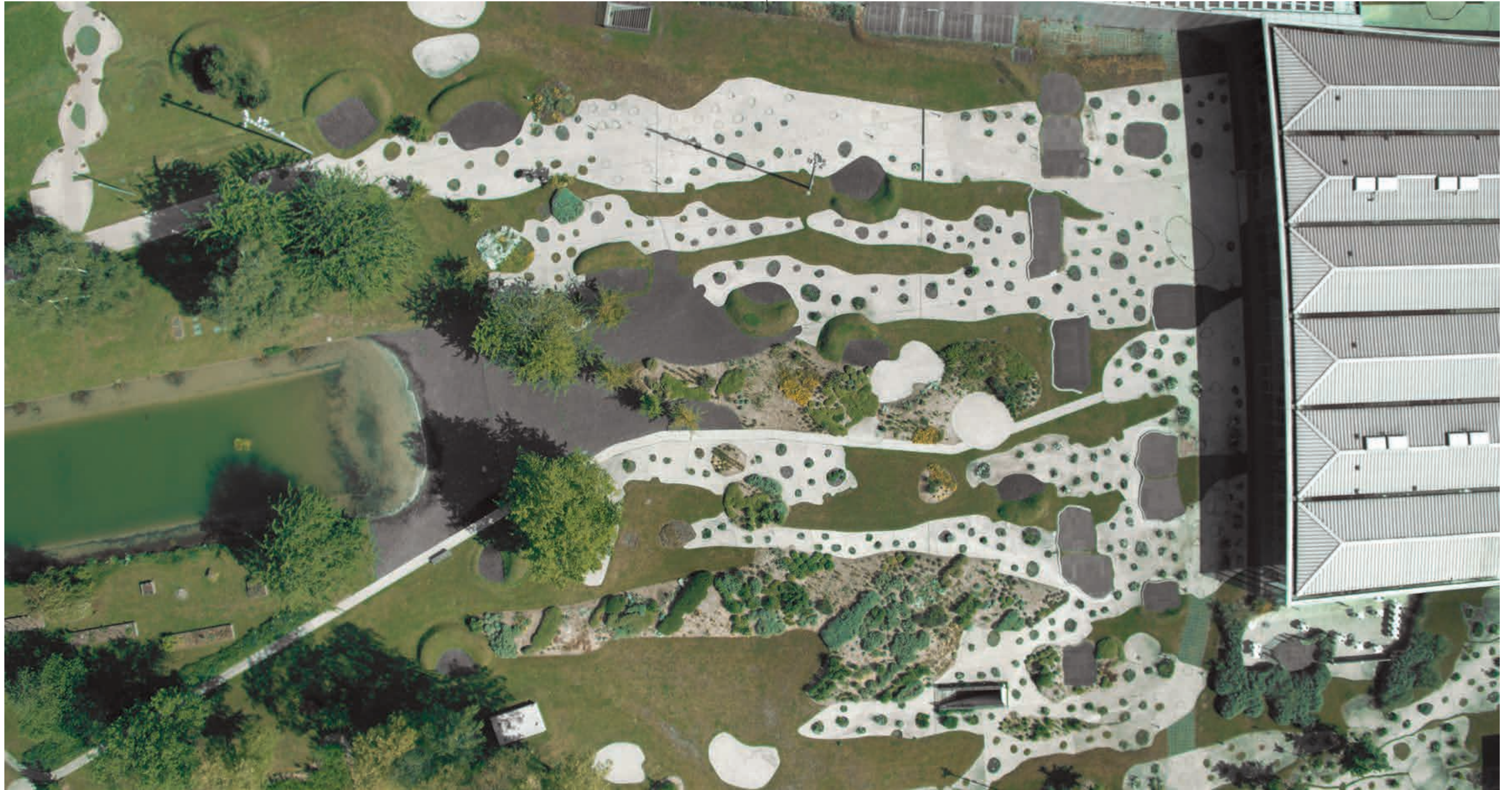
Cette vue zénithale de la Terrasse des arts dévoile le subtil travail sur les sols, agrémentés de gouttes drainantes qui accueillent des plantes essentiellement persistantes de milieux steppiques ou rocailloux.
