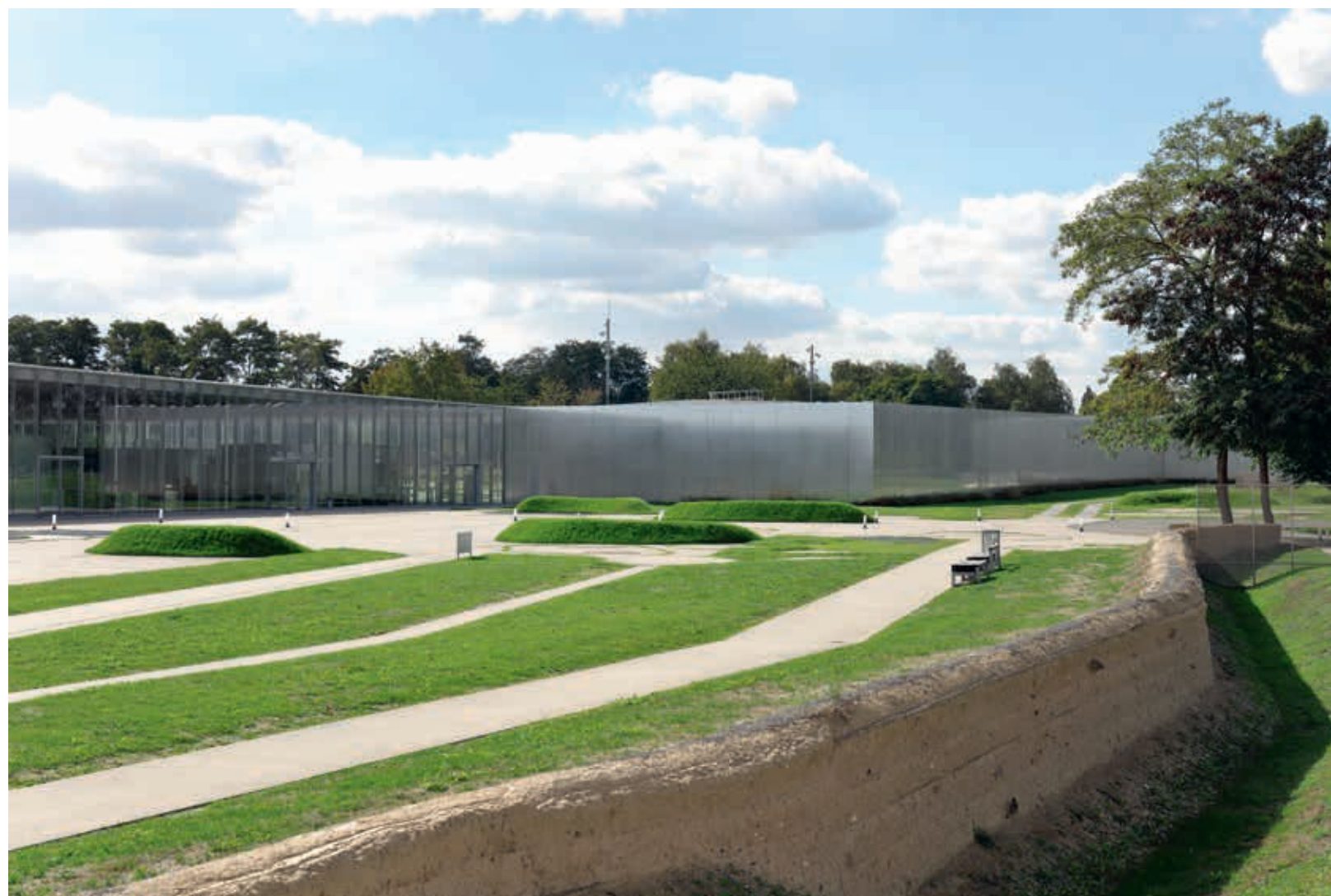
Le site du Louvre-Lens est un terril plat. Le muret en pisé a été élevé à partir des limons qui recouvraient initialement le sol sur l'emprise des bâtiments : il expose au regard une mémoire géologique du lieu.
