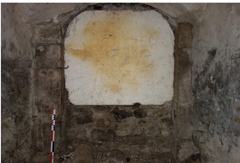
Fig. 34 - Porte dans l'aile nord (POR 2060) vue depuis l'intérieur.
