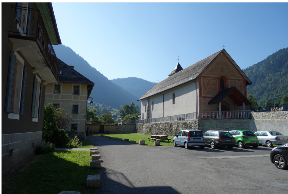
Fig. 8 - Site abbatial d'Entremont. À droite, l'église paroissiale (sud) et à gauche, l'aile nord du couvent. Entre les deux se trouve la parcelle n° 16.
