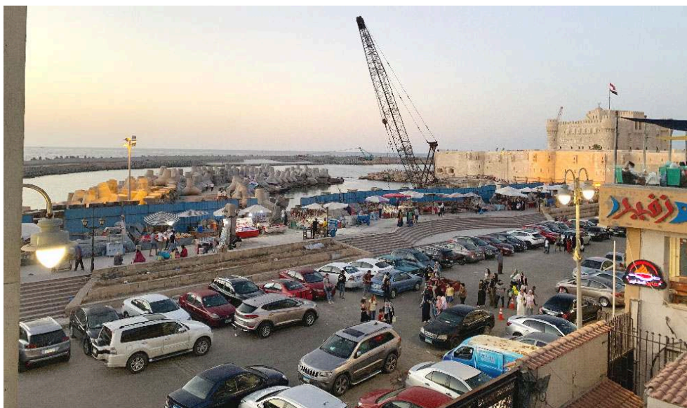
Fig. 104. Site du Phare. Vue de la nouvelle digue (M-D. Nenna).
