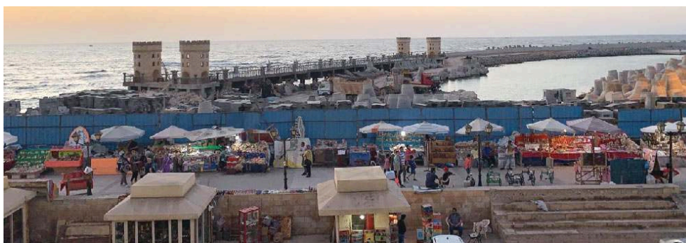
Fig. 103. Site du Phare. Vue du pont reliant la nouvelle digue à la chaussée conduisant au fort Qaitbay (M-D. Nenna).
