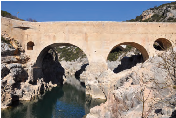
Fig.14 : Le pont dit aujourd'hui du Diable (autrefois du Gouffre Noir) a été mis en œuvre vers le milieu du XIe s. par les abbayes d' Aniane et de Gellone . Il modifie le franchissement de l'Hérault qui s'effectuait plus en aval au « gué royal » situé entre Aniane et Saint-Geniès de Litenis (Cliché L. SCHNEIDER 2012).
