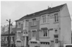
Rue de la Parmentière, immeuble années 40
