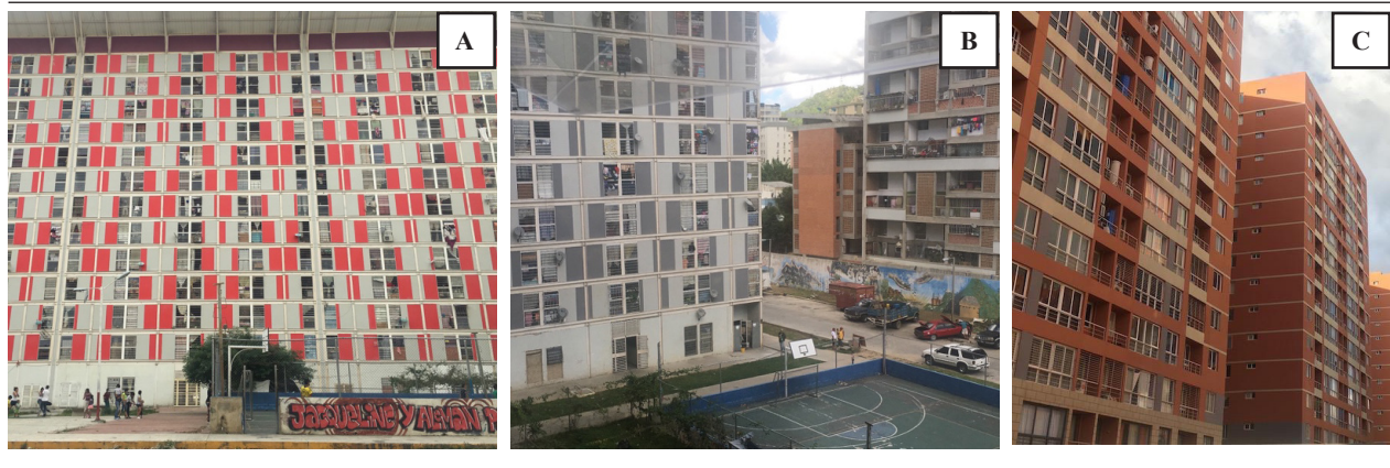
Figura 7a y 7b. GMVV, paneles en PVC, Montalbán, Caracas.
