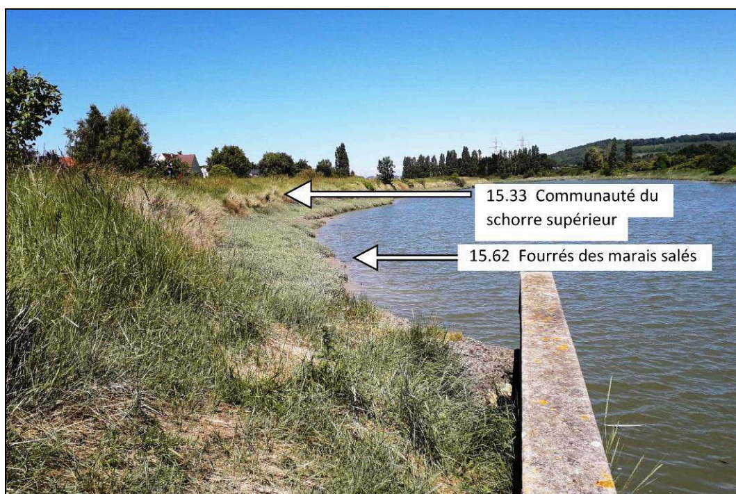
Photo 6 - Une digue et son environnement proche en bordure de la Dives.
