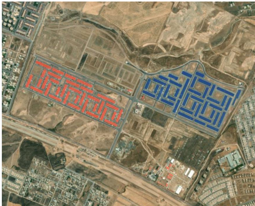
Document n° 4 : Etat projet « village coréen » à Erbil après l'arrêt définitif du chantier. Source : Zoom Earth, image 2019.
