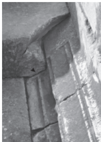
Fig. 12 — Base de l'Asiarque. Facettes d'épannelage non ravalées sous la première marche de l'escalier. La facette inférieure (flèche) correspond à une ligne du dessin.
