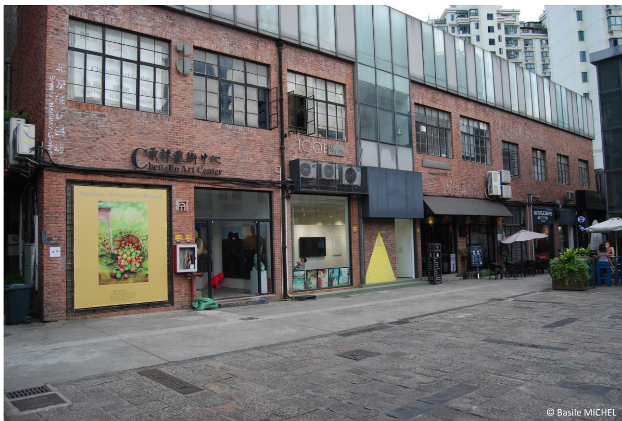
Figure 2 : Un ancien bâtiment industriel reconverti en galeries d'art au M50
