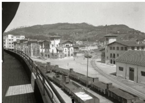
Fig. 10 – Edificios principales del puerto y ferrocarril de mercancías (1945).
