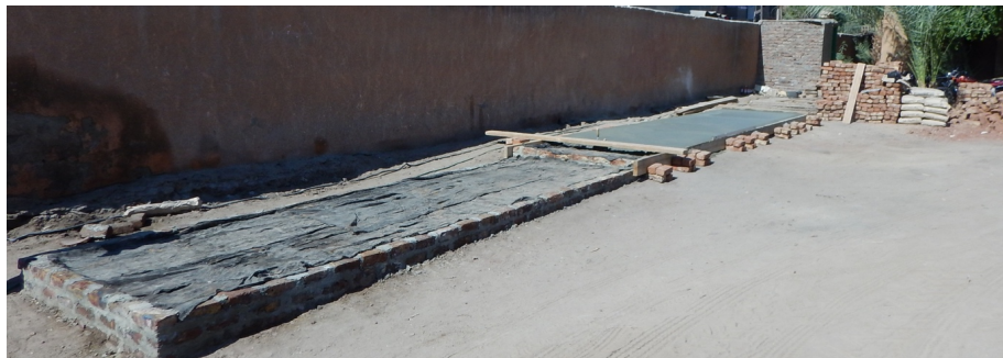
Fig. 14. Construction en cours d'une banquette (dépôt lapidaire). © CNRS-CFEETK/Chr. Thiers.
