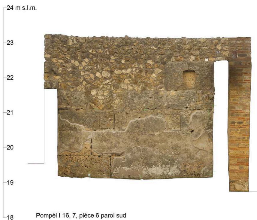
Fig. 7. Photogrammétrie de la paroi sud de la pièce (6) de I 16, 7, avec indication des fenêtres bouchées.
