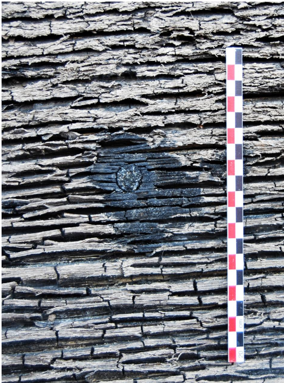
Figure 2 : Photographie de détail d'un trou de jauge où s'observe les restes de matière d'étanchéité (Cliché : F. Blondel).
