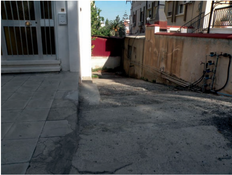
Figure 5 : Le dénivelé vu depuis la rue Teukros (point n° 5), vers le nord-ouest (Mission de Kition, 2009).
