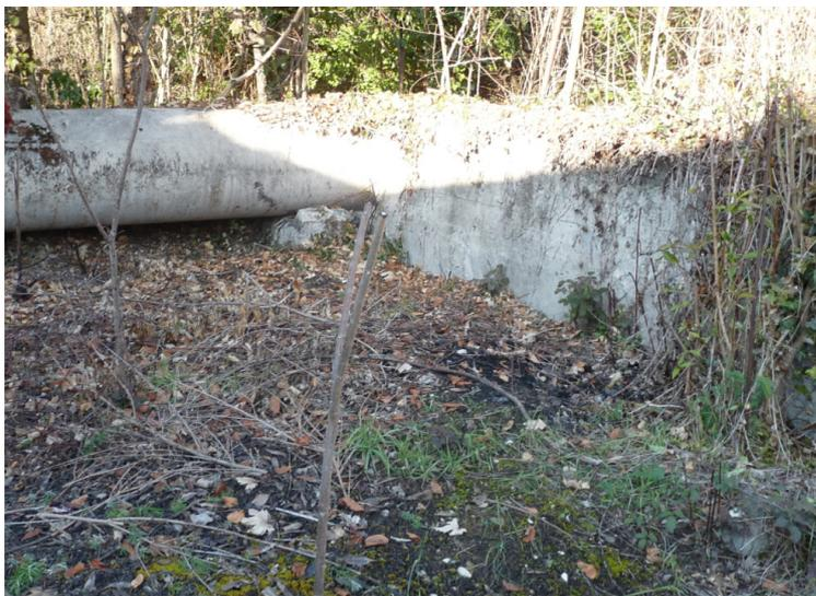
Figure 10. Tuyau en ciment de 80 cm de diamètre alimentant en eau le bassin nord visible à gauche, rappelant les tuyaux en ciment fabriqués sur le site de l'usine de La Grande.
