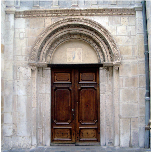
Fig. 24. Linteau et piédroits en choin du portail Saint-Laurent (nord) de l'église Saint-Paul (Lyon). Cliché : Gh. Macabéo, Inrap-UMR 5138.
