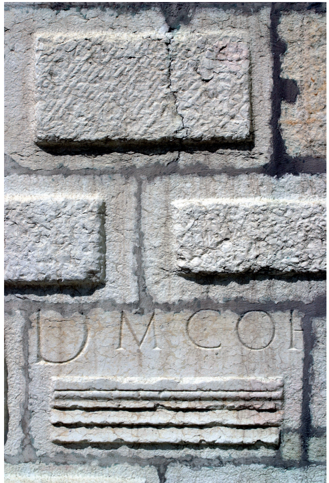
Fig. 6. Blocs antique employés à la base des murs, cathédrale Saint-Jean-Baptiste (Lyon), comme au pied de la chapelle Notre-Dame-du-Haut-Don. Cliché : J.-P. Gobillot, photographe.
