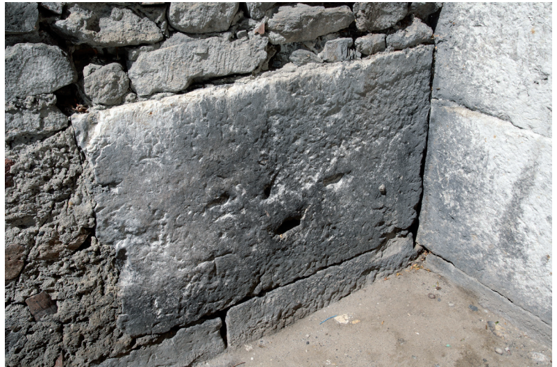
Fig. 18. Soubassement du mur gouttereau sud, 1 ère travée : parement extérieur de l'église abbatiale Saint-André-le-Haut de Vienne (Isère). Cliché : A. Baud et A. Flammin, Université Lyon 2-UMR 5138.
