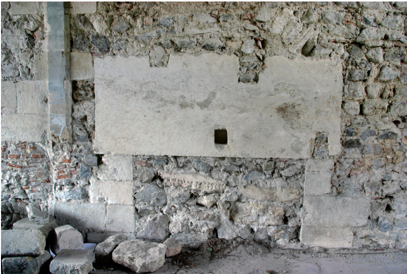
Fig. 25. Linteau de la porte gothique du mur gouttereau nord (parement nord) de l'église abbatiale Saint-André-le-Haut de Vienne (Isère). Cliché : A. Baud et A. Flammin, Université Lyon 2-UMR 5138.
