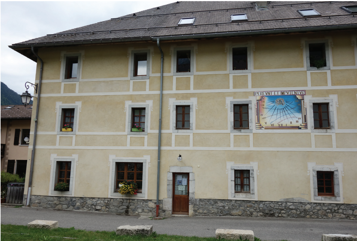
Fig. 21 - Moitié occidentale de la façade sud de l'aile nord.
