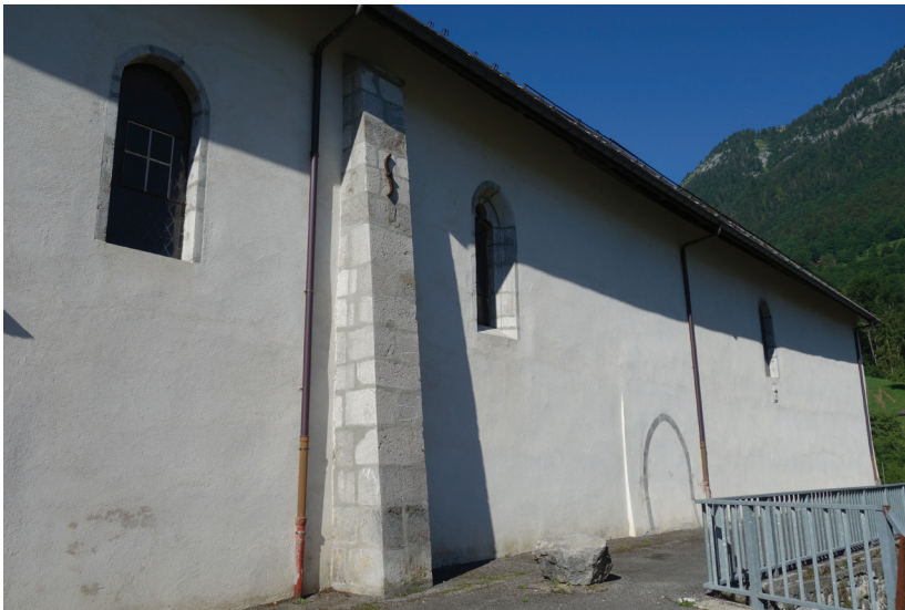
Fig. 9 - Mur gouttereau nord de l'église et porte condamnée.
