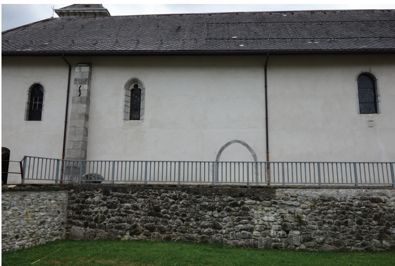
Fig. 11 - Mur de soutènement de la terrasse de l'église et porte condamnée.
