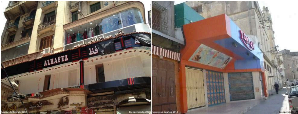
Fig. 6. Au Muski (à gauche) et à Médina J'dida (à droite), les devantures rénovées des locaux commerciaux contrastent fortement avec le bâti existant
