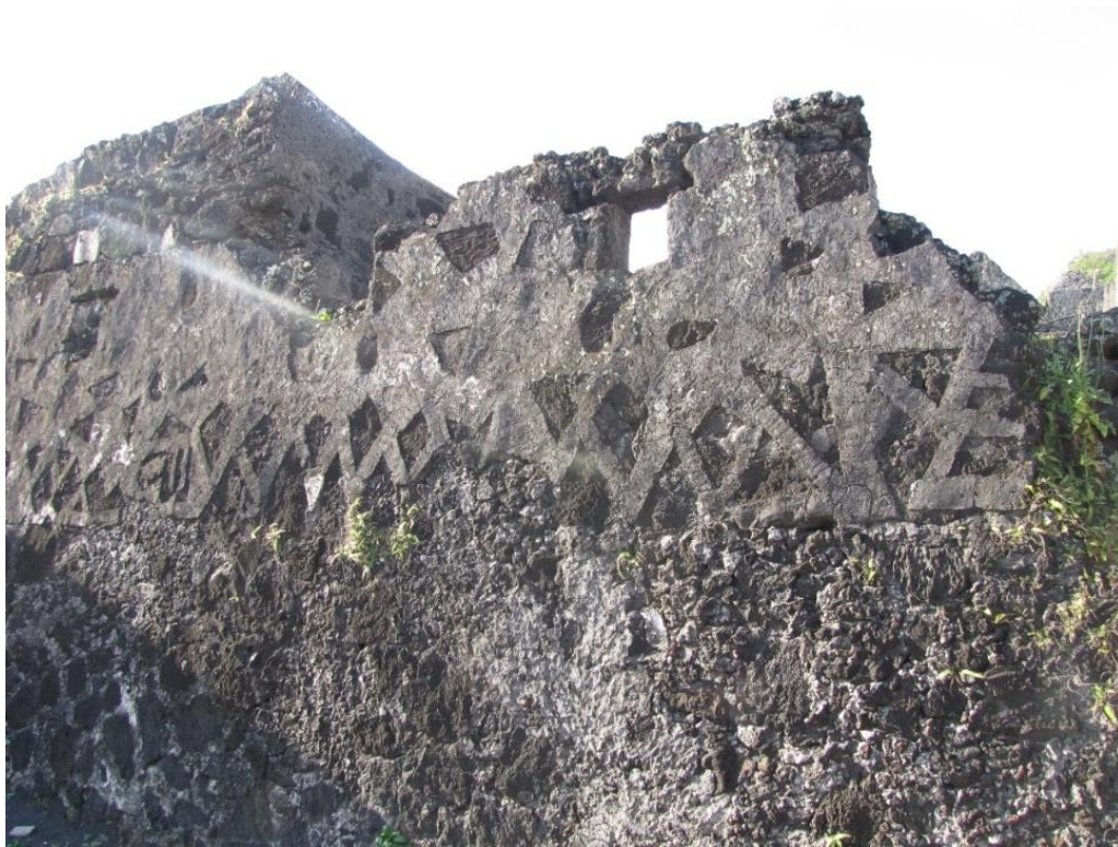
Figure 154 : Mur sud du palais
