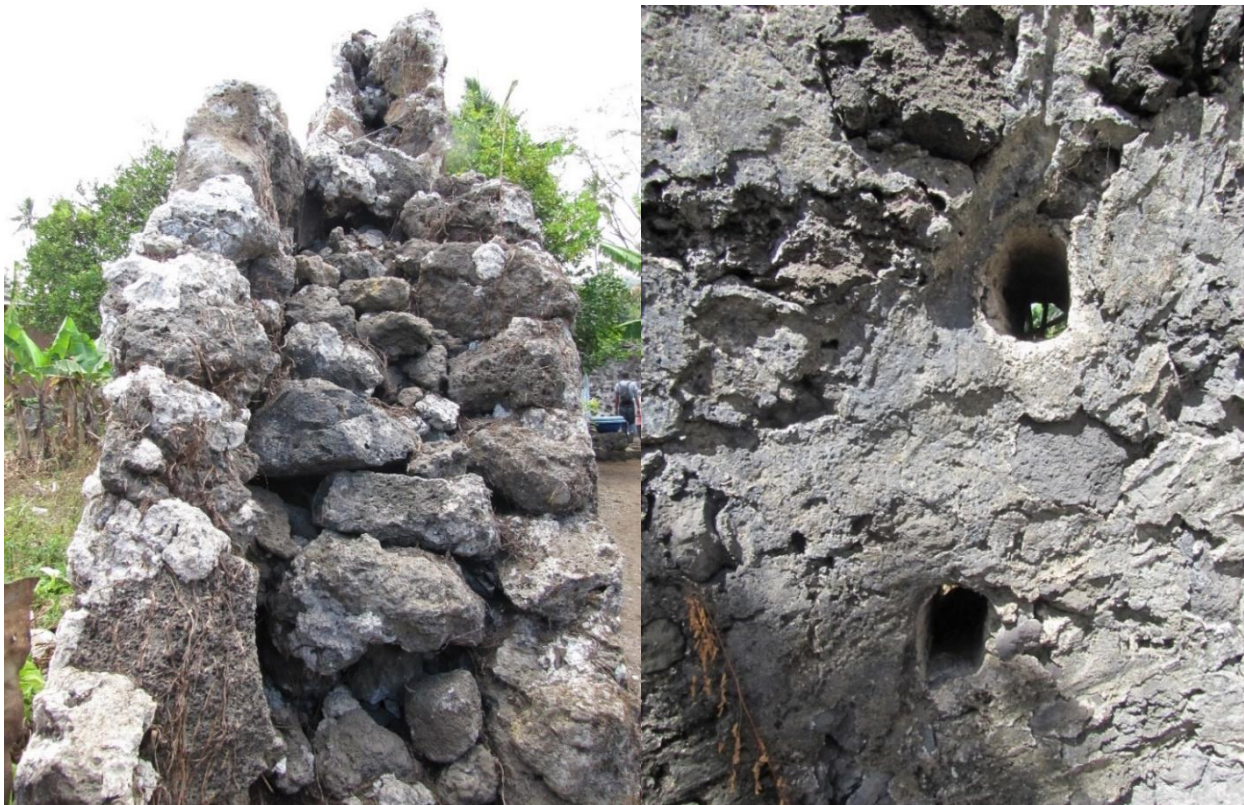
Figure 86 : Fourrage interne du ngome ; trous de boulin traversants de section ronde (détail)
