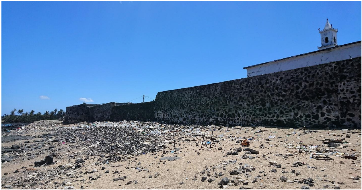
Figure 70 : Rempart ouest, Ntsaweni, Grande Comore
