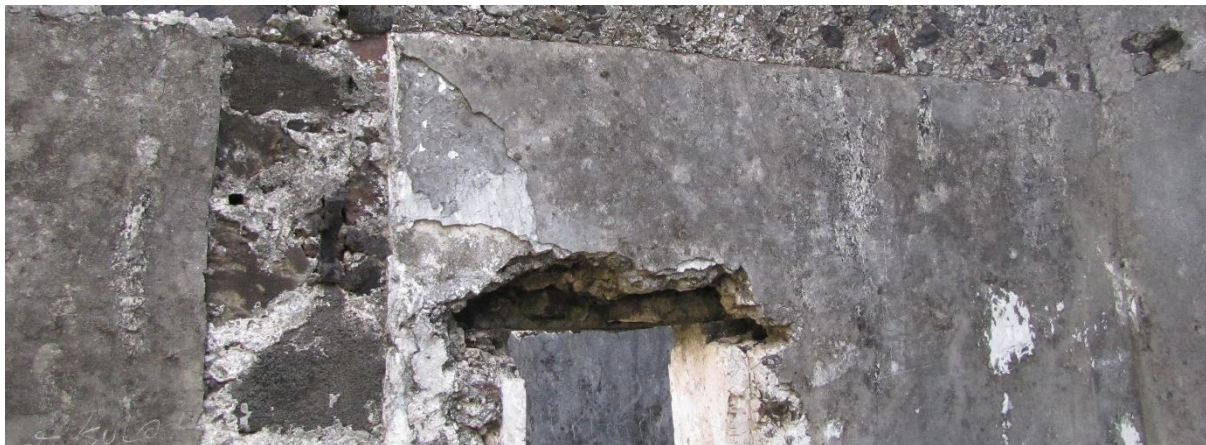
Figure 156 : Porte Ic003, détail du linteau
