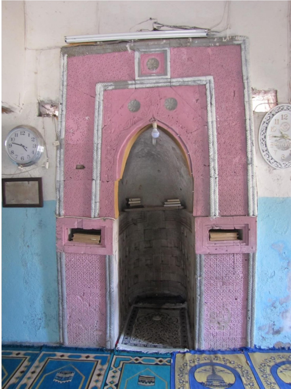
Figure 96 : Ntsaweni, élévation du mihrab de la mosquée Djumbe Fumu
