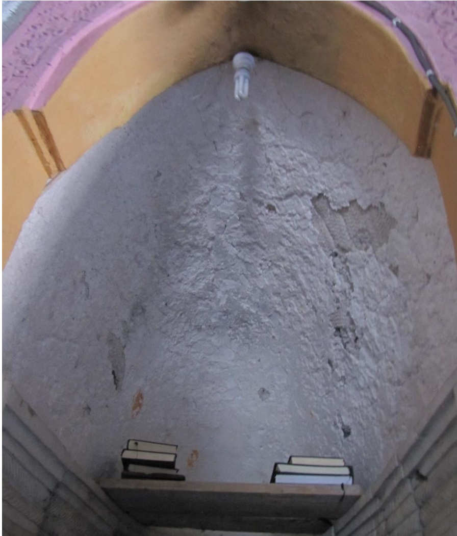
Figure 99 : Couvrement en cul-de-four de la niche du mihrab
