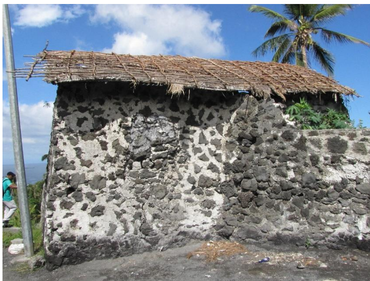
Figure 81 : Ntsudjini, bunarisi avec couvrement restitué
