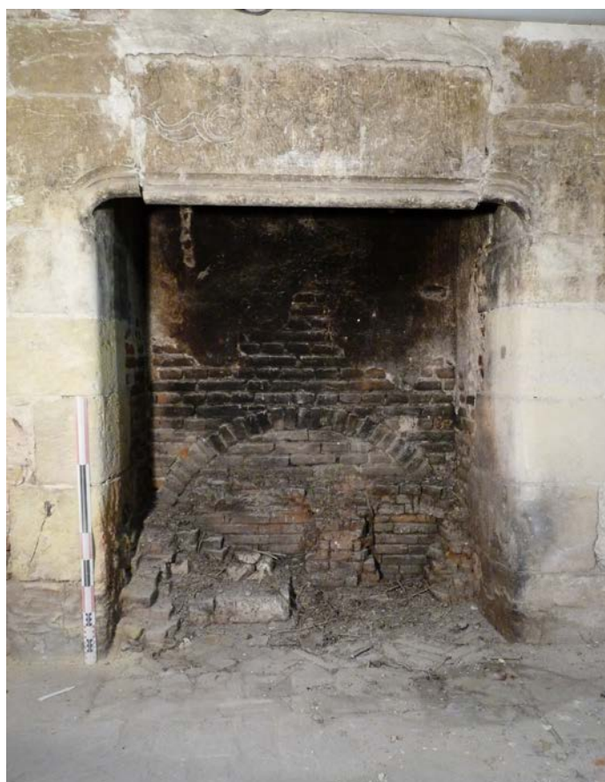
Fig. 2 : Cheminée supportant la peinture © Département du Loiret - SAP.
