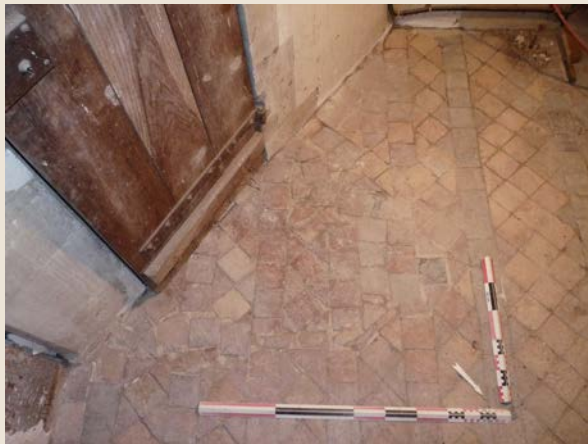
Fig. 6 : Sol pavé de la chambre haute nord © Département du Loiret - SAP.
