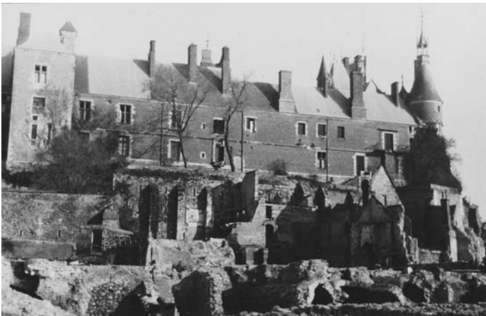
Fig. 20 : Vue des ruines des maisons accolées au coteau sud après le bombardement de 1940 : les toits du château ont subi des dommages, ils sont recouverts de cartons bitumés et de bâches © Médiathèque de l'architecture et du patrimoine.
