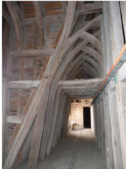
Fig. 9 : Galerie de circulation à pan de bois, charpente est, restée inachevée © Département du Loiret - SAP.
