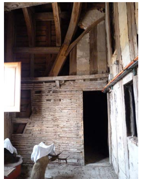
Fig. 10 : Galerie de circulation à pan de bois, charpente est, restée inachevée © Département du Loiret - SAP.
