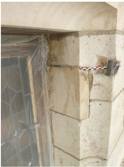
Fig. 6 : Moulure à cavet, fenêtre à meneau, 1 er étage © Département du Loiret - SAP.
