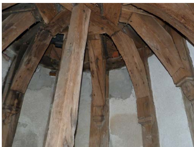
Fig. 7 : Aisseles sculptés de la tourelle d'escalier de la tour ouest (Bizri, Marchant, Perrault 2019).
