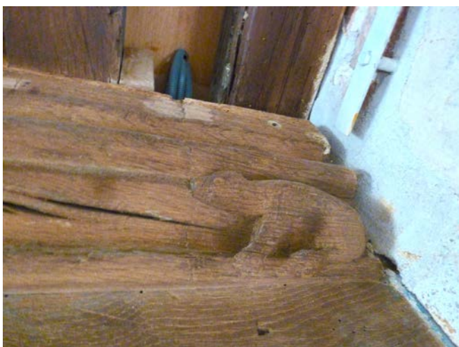
Fig. 6 : Ours sculpté sur les extrémités de cette poutre (Bizri, Marchant, Perrault 2019).
