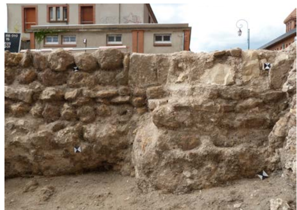
Fig. 5 : Détail d'un contrefort © Département du Loiret - SAP.
