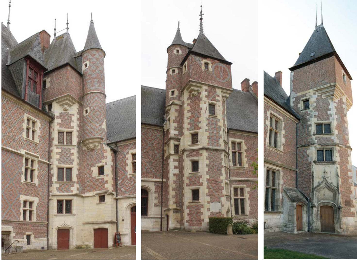
Fig. 1 : Tours d'escalier à chambre haute est, nord et ouest © Mélinda Bizri.
