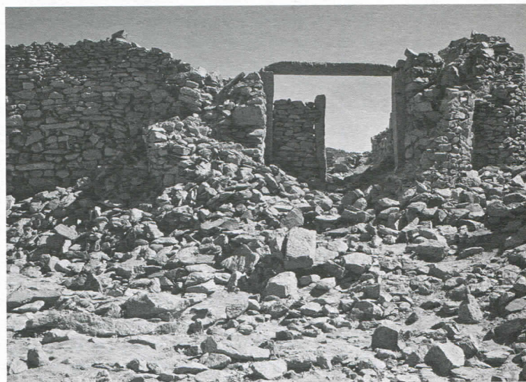
Fig.4 – La porte du village fortifié dans le wadi Umm Hussein au Mons Claudianus. Encadrée par deux tours rondes, elle a été réduite en largeur et le dispositif complété par une chicane (© A. Bülow-Jacobsen).
