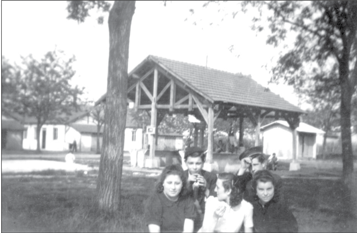
Image 5 – Le lavoir et les toilettes, seuls équipements collectifs des cantonnements. Cliché Q6, dépôt famille Garcia (© coll. CIE Rhodia Roussillon).
